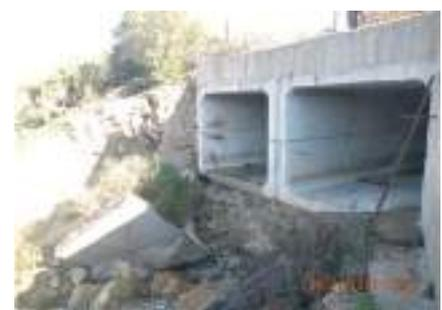
Figura 6. Rotura aletas en marco prefabricado
