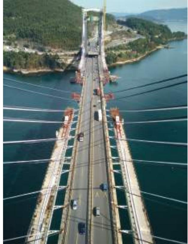
sus fustes, un nuevo tablero metálico cuya base está formada por un cajón y una celosía exterior metálicos, y una losa superior de hormigón armado; esta estructura se ha unido mediante celosías interiores metálicas ancladas al tablero original mediante rótulas.
