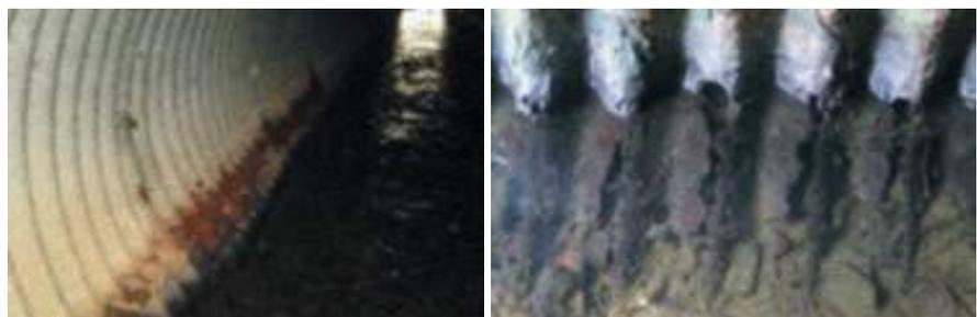
Figura 2. Tubos de acero corrugado dañados por corrosión.
