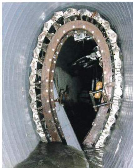
Figura 7. Proceso de enrollamiento espiral
