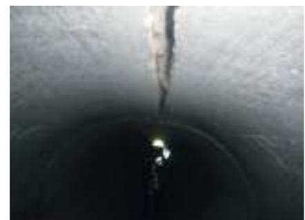
Figura 5. Tubo de hormigón con rotura longitudinal en generatriz superior e inferior
