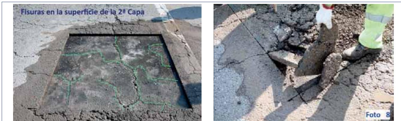
Figura 17 y 18. Falta de adherencia entre la capa de rodadura y la intermedia
