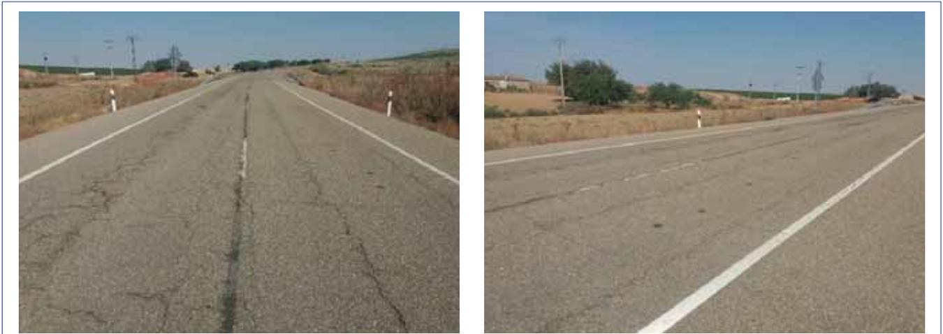
Figuras 3 y 4. Fisureación en rectángulos
