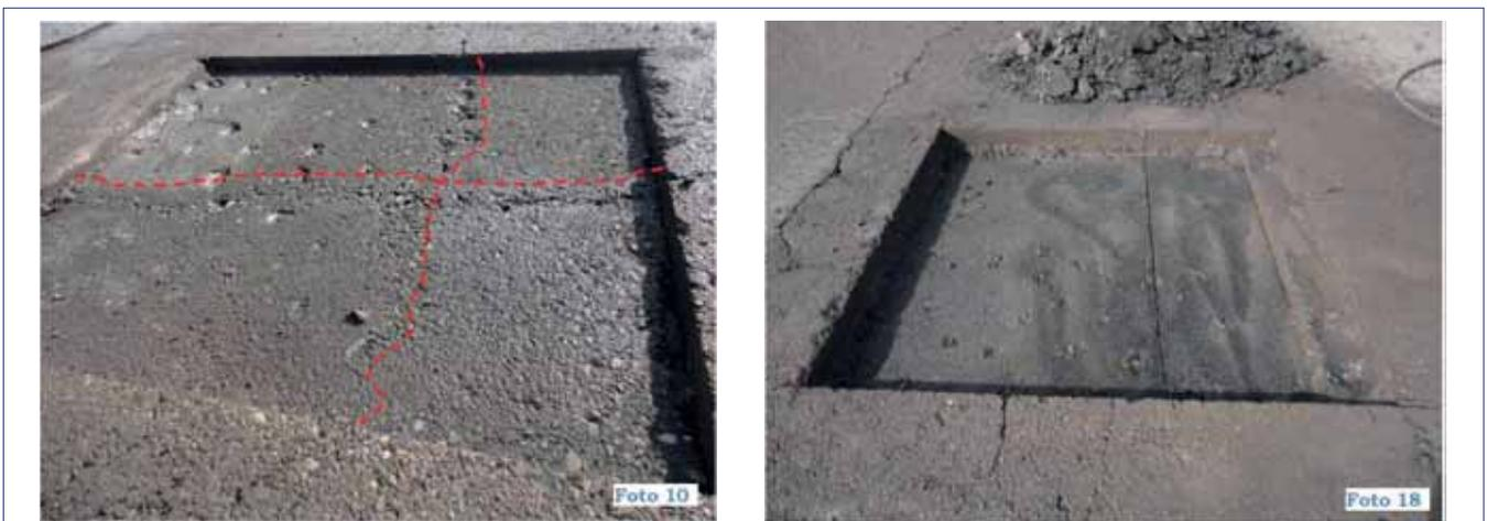
Figura 24 y 25. Continuación de la fisuración sólo en la segunda capa
