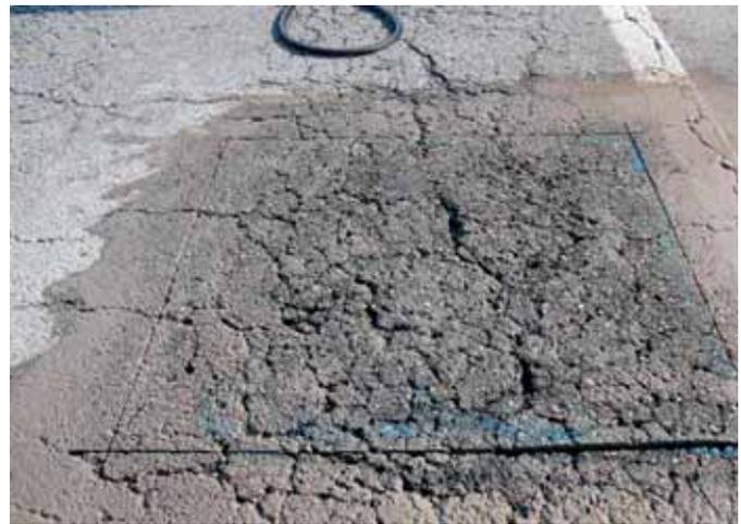
Figura 15 y 16. Agrietamiento importante de la capa de rodadura
