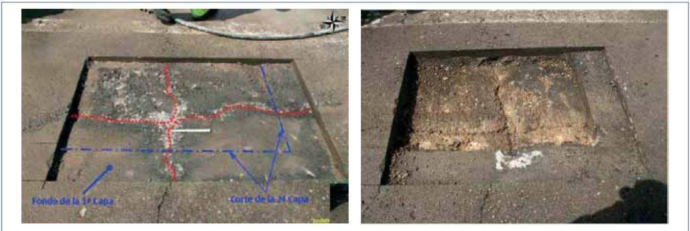
Figura 21 y 22 Fisuración por reflexión de las grietas de retracción de la gravacemiento
