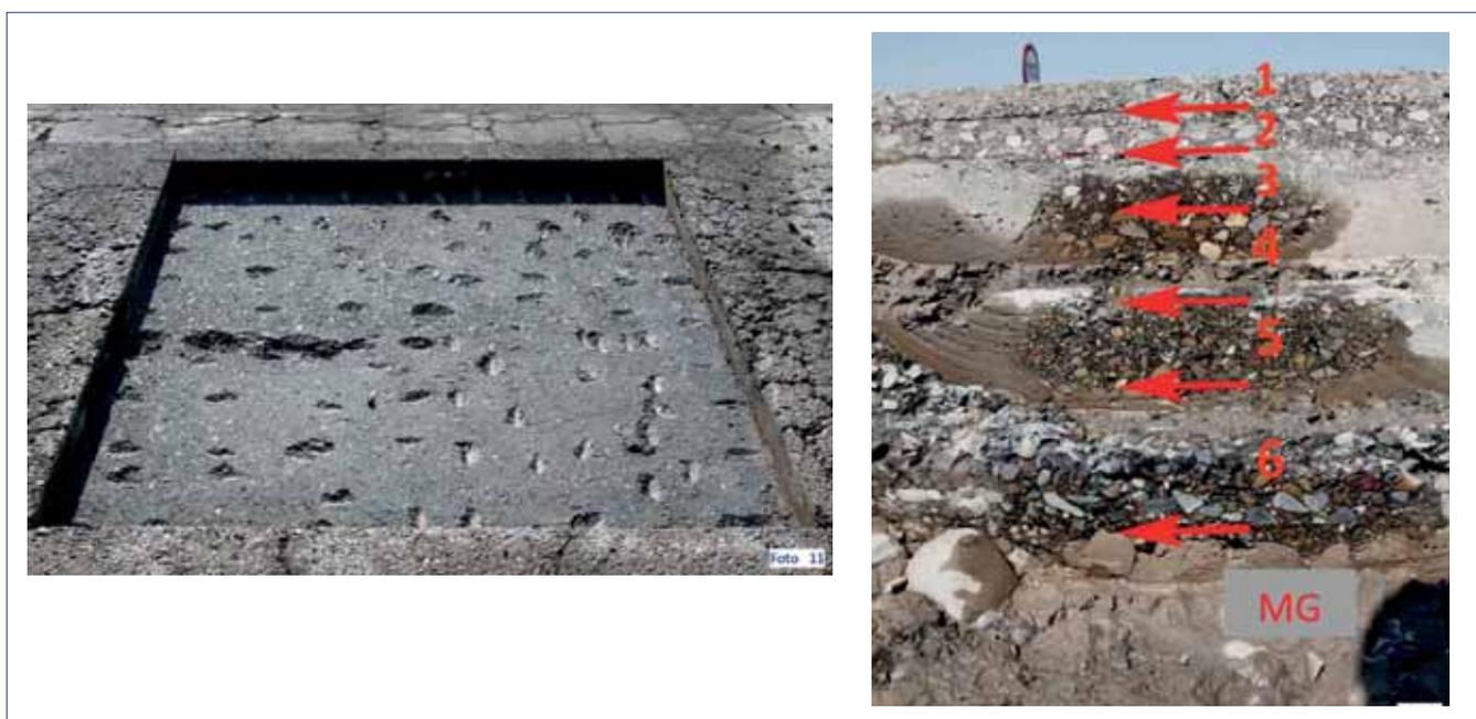
Figura 19 y 20. Desaparición del agrietamiento en la 3ª capa y corte de la calicata
