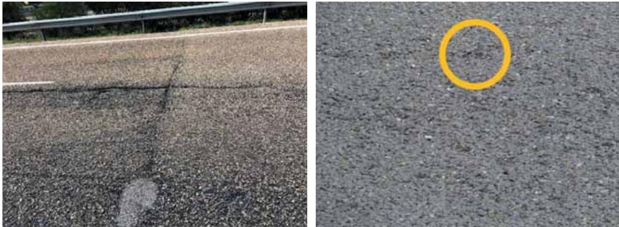
Figura 33 y 34. Pérdida de gravilla en capas de rodadura drenantes
