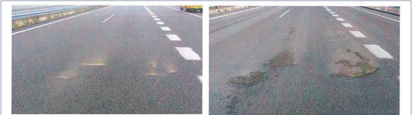
Figura 31 y 32. Ascenso de finos del suelocemento a la superficie de rodadura
