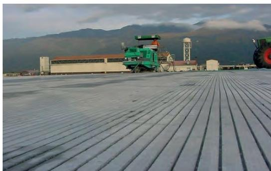
Figura 3. Textura de ranurado por disco de diamante [1]
