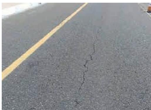
Figura 9. Reflejo en el pavimento de una de las grietas existentes en el tablero (Estructura de la carretera SG-20)
