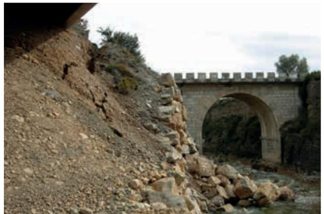
Figura 11. Fotografía del 6 de marzo de 2013, unas tres horas después del paso del pico de la avenida: caída del muro, grietas y asientos en cono de tierras del estribo norte del viaducto de 2002 (a la izquierda) y erosión en estribo sur del puente de 1940 (a la derecha de la imagen), que a partir de entonces empezó a funcionar como cauce de aguas bajas
