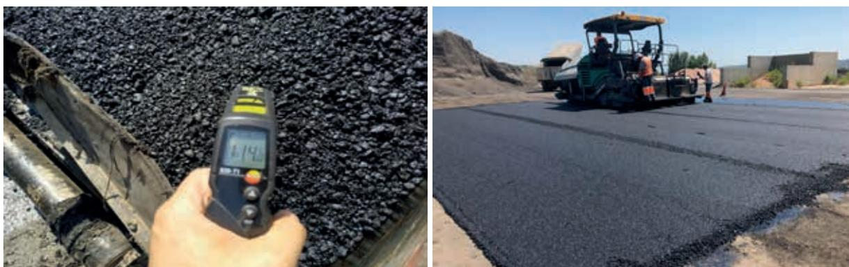
Fotografías 9 y 10. Mezcla bituminosa en la tolva de la extendidora (izquierda) y extendido en tres franjas (derecha).
