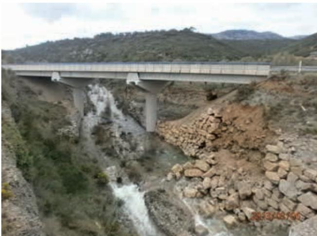
Figura 10. Fotografía del 6 de marzo de 2013, unas tres horas después del paso del pico de la avenida: obsérvese la caída del muro de escollera de protección del estribo y la poza de socavación en la margen contraria
