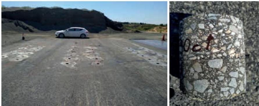
Fotografías 15 y 16. Tramo experimental después de la extracción de testigos (izquierda) y aspecto de uno de los testigos extraídos (derecha).
