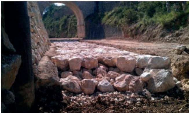
Figura 19. Detalle de inserción de muro de escollera y semisección del lecho del cauce (ver además la Figura 15)
