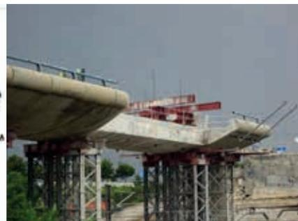
Figura 20. Desmontaje del tablero existente
