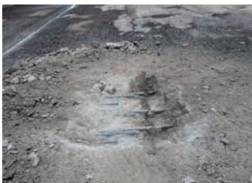
Figura 13. Barras seccionadas en la estructura de la carretera SG-20
