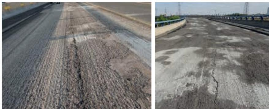
Figura 8. Fisura longitudinal observada en la cara superior del tablero (A la izquierda, estructura de la carretera SG-20; a la derecha, estructura del Nudo de Colmenar)
