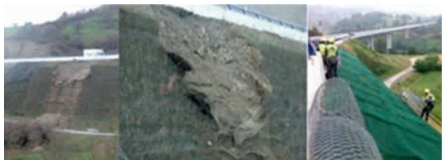
Figura 13. Muro verde con bulones autoperforantes en la autovía A-67.
