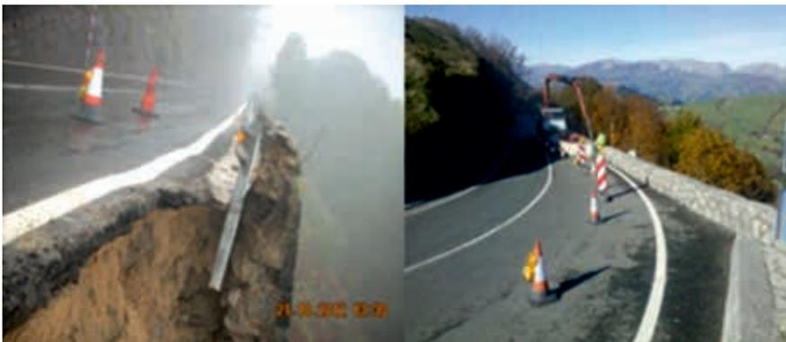
Figura 15. Hundimiento de la plataforma de la carretera N-629 causado por las fuertes lluvias y señalización provisional
