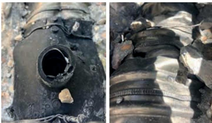
Figura 18. Falta de conexión entre tubo de purga y vaina de pretensado (Estructura del Nudo de Colmenar)
