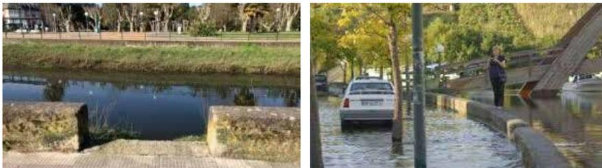
Figura 6. Interrupciones murete de malecón para acceso de embarcaciones
