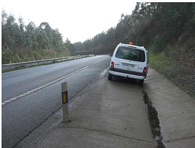
Figura 5. Cuneta de sección: 6H:1V + 4H:1V. Obsérvese la fuerte inclinación del automóvil del lado 6H:1V.
