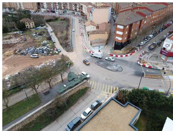
Figura 9. Glorieta C/ La Florida en la N-234
