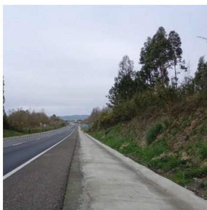
Figura 3. Cuneta de seguridad 10H:1V (después)
