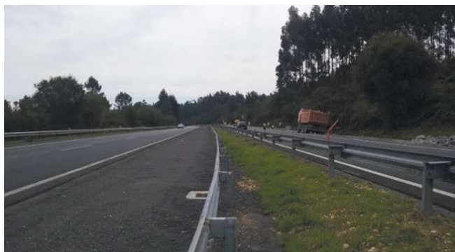
Figura 13. Barrera retranqueada y cuneta de seguridad 10H:1V
