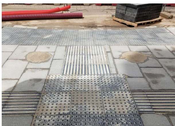
Figura 2. Pavimentación podo-táctil en cruces y pasos de peatones
