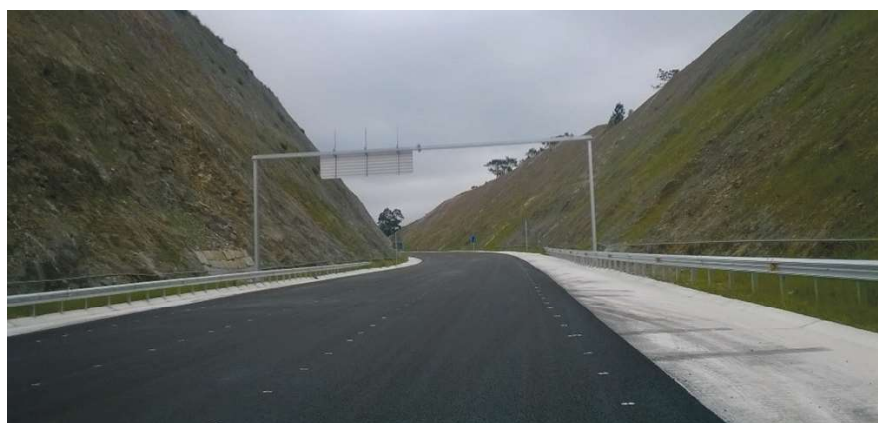
Figura 16. La barrera se sitúa detrás de la cuneta. El obstáculo (póste de pórtico) sigue protegido.
