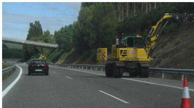
Figura 18. La desbrozadora no se puede arrimar a la cuneta por ser innecesariamente profunda, lo que exige una barrera. Otro diseño más benigno es posible
