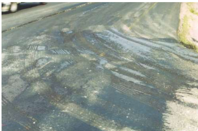
Figura 7. Problemas presentados con emulsiones de adherencia convencionales
