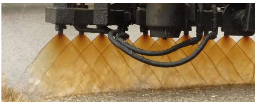
Figura 11. Detalle de los abanicos del riego de adherencia. Fuente web de IBEF.
