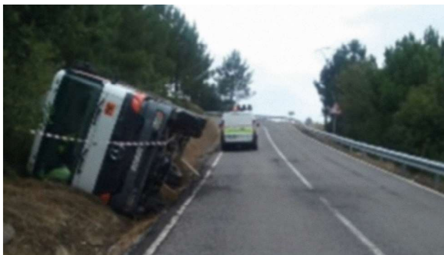
Figura 1. Vuelco en cuneta triangular profunda
