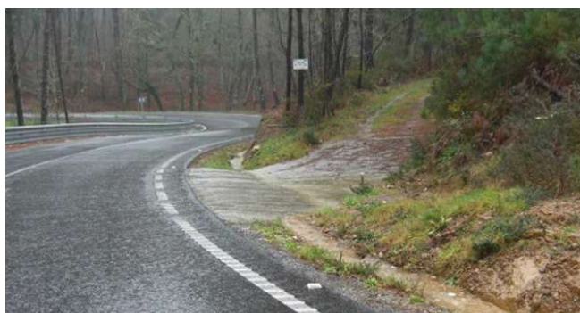
Figura 26. paso vadeable con cuneta de seguridad
