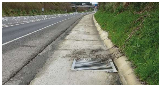
Figura 21. barrotes transversales, son más seguros para vehículos de dos ruedas
