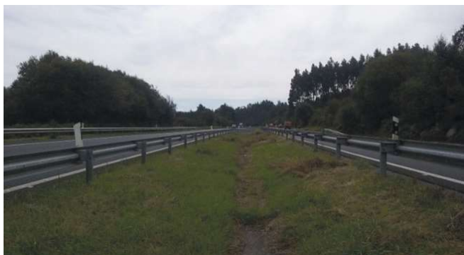
Figura 12. Barrera situada al lado del arcén
