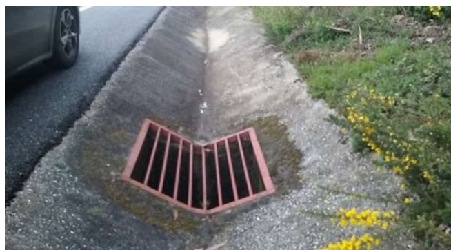
Figura 19. Ejemplo de sumidero con barrotes longitudinales
