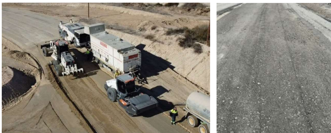
Figura 11. Equipo de estabilización in situ y aspecto de la capa estabilizada.
