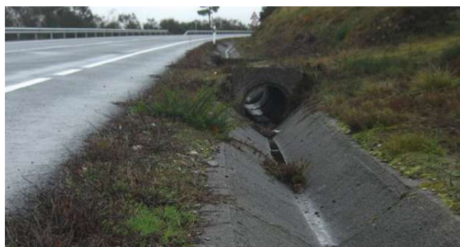
Figura 25. Cuneta triangular con salvacunetas
