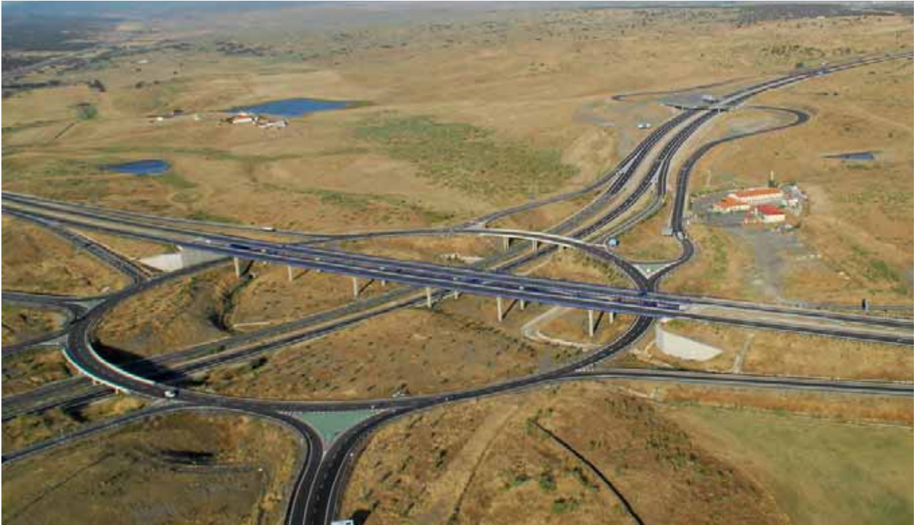
Enlace inicial con A-66. Gran glorieta cruzada en su parte superior por la A-66, en dirección norte-sur; y en su parte inferior, en dirección este-oeste, por la EX-A1
