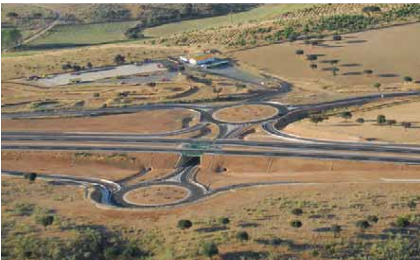
Enlace 1, de tipo diamante con glorietas, para la conexión con las localidades de San Gil y Galisteo
