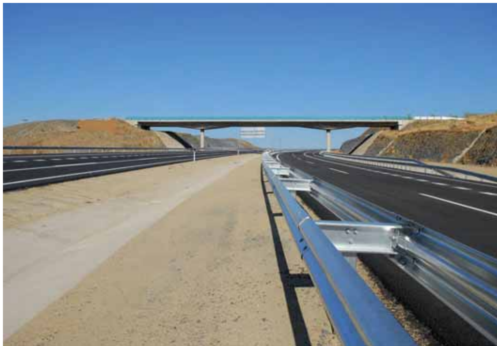
A lo largo del trazado se han dispuesto cuatro pasos superiores resueltos por medio de estructuras hiperestáticas postesas de tres vanos sin pila mediana, construidas por medio de cimbrado
