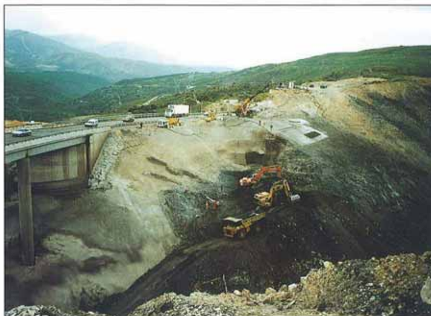
Sostenimiento del talud izquierdo, pk 51+200. Tramo Manzanal-San Román.
