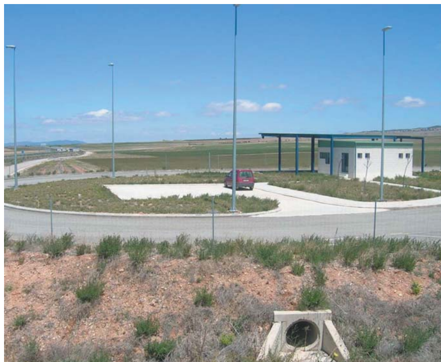
Figura 1. "Estación de Pesaje en la A-23. Término municipal de Villafranca. Teruel". Fuente: "Ministerio de Fomento"
