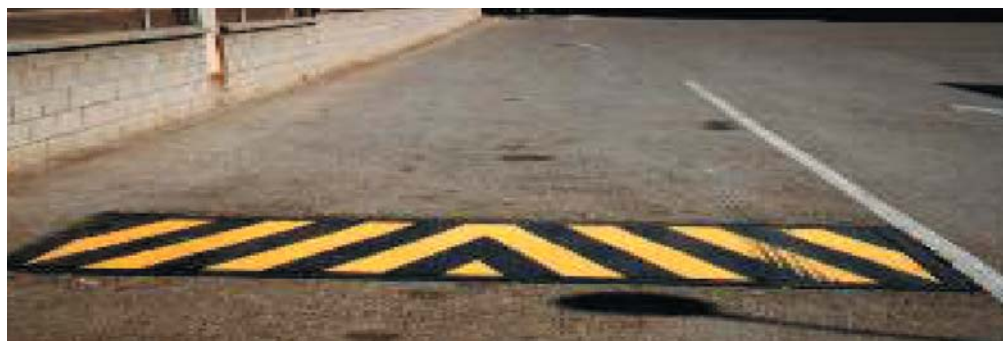
Figura 4. Detalle de una báscula de pesaje estático o dinámico a baja velocidad. Fuente: "TECBAS".
