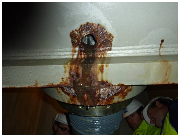
Figura 4. Purgas de tubo de encofrado con presencia de corrosión
