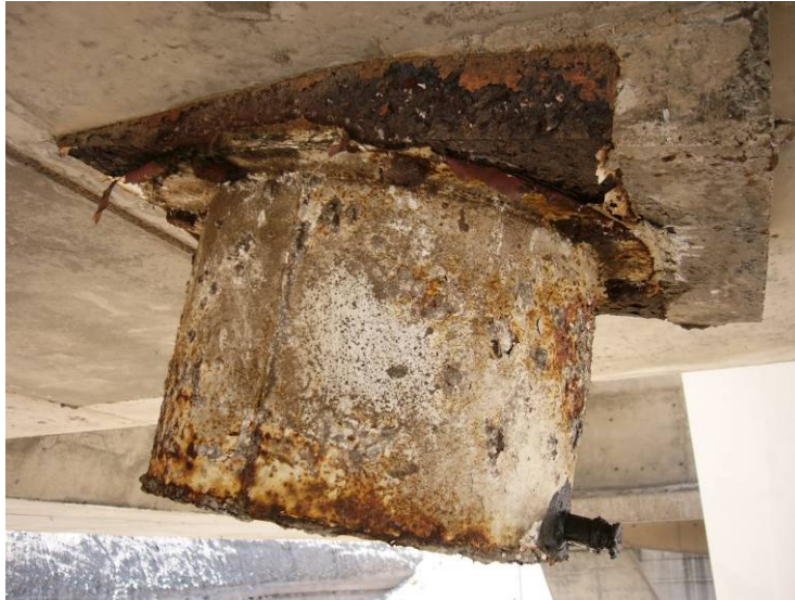
Figura 3. Corrosión en el exterior del capot
