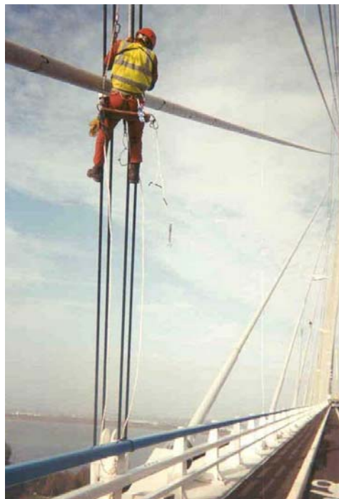
Figura 17. Inspección con alpinista en el puente de Normandía
