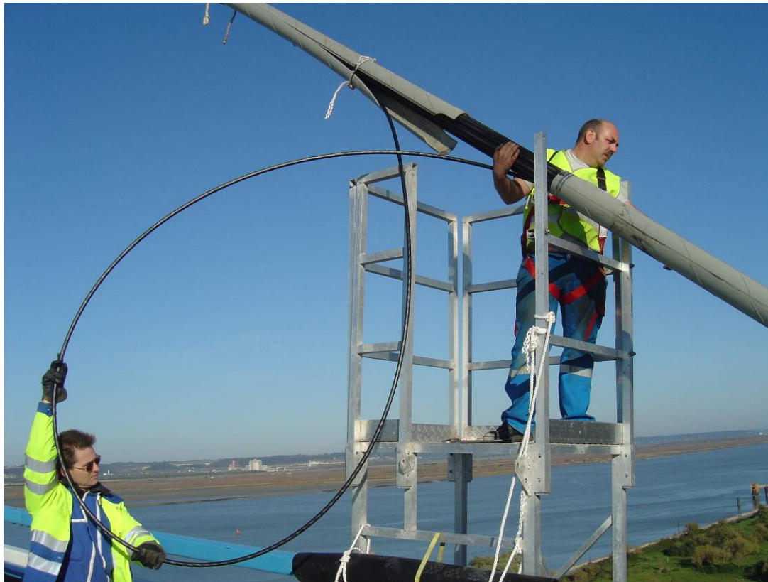
Figura 2. Extracción y sustitución de un cordón en el puente de Normandía.
