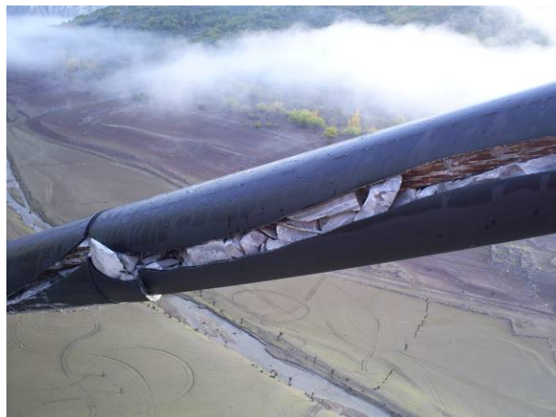
Figura 10. Filtración de agua, expansión de lechada, rotura de vaina y corrosión de los cordones
