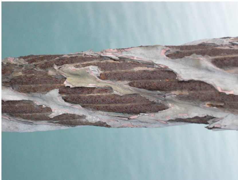
Figura 8. Protección contra la corrosión dañada. Péndolas del puente de las Américas . Panamá,
