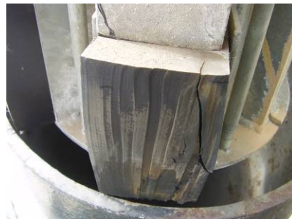
Figura 14. Pistones de elastómeros reptados fuera del tubo de encofrado por oscilaciones del tirante.
