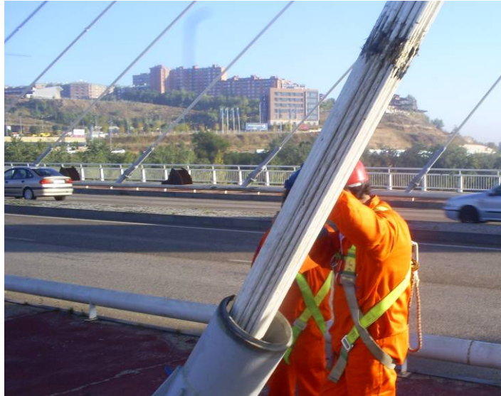
Figura 11. Exceso de desvío en haz de tirante
