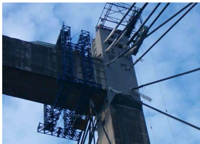
Figura 27. Acceso al exterior del pilono en el Puente de Rande
