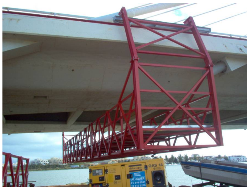
Figura 15. Pasarela inferior motorizada en el puente de Arade – Portugal.
