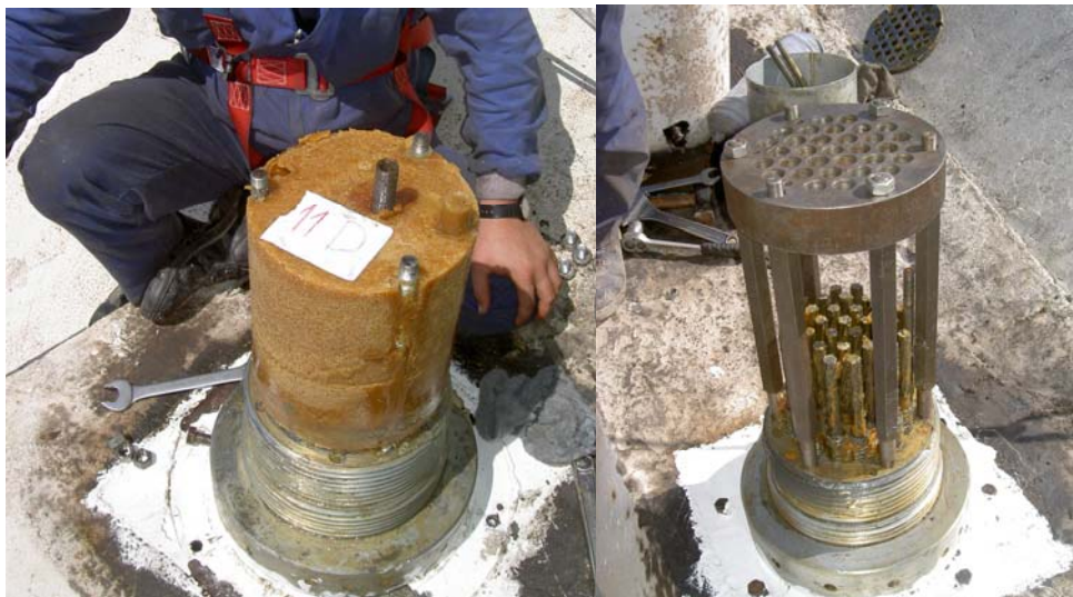
Figura 28. Inspección del interior del anclaje superior del Viaducto de Tamaraceite
