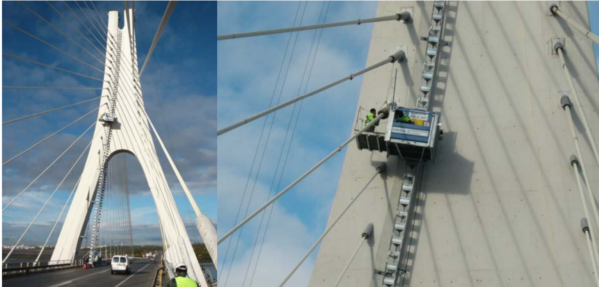
Figura 26. Inspección de los anclajes superiores del Puente de Arade
