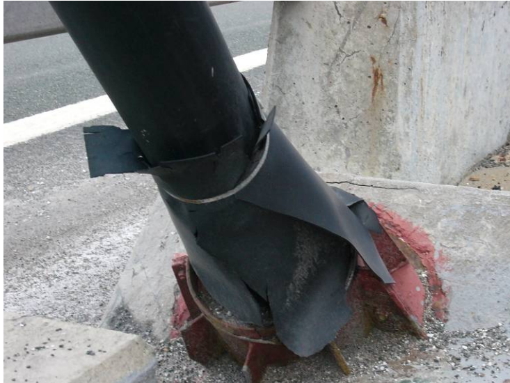
Figura 7. daños en faldón de conexión entre vaina y tubo guía,
