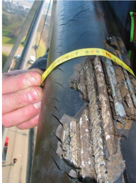
Figura 9. Rotura de vaina de cubrición, falla de lechada y corrosión de los hilos paralelos,
