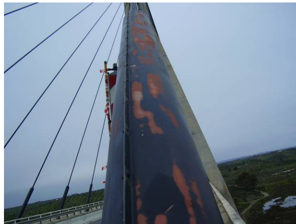
Figura 6. Erosión de pintura en tubos antivandálicos por proyección desde la calzada
