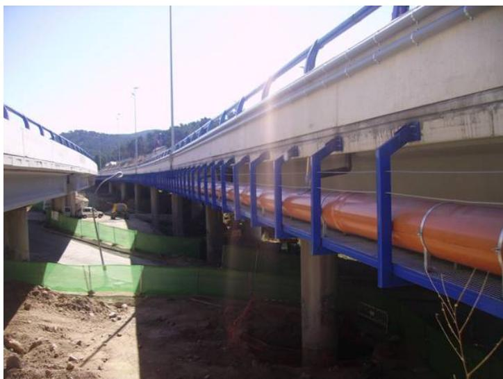
Finalmente, el análisis técnico-económico concluyó en que la solución más adecuada era la de demoler los viaductos existentes y reconstruir los mismos con la sección ampliada. Como una estimación suficientemente aproximada, se puede decir el coste de demolición y reconstrucción de la estructura original era prácticamente del mismo
