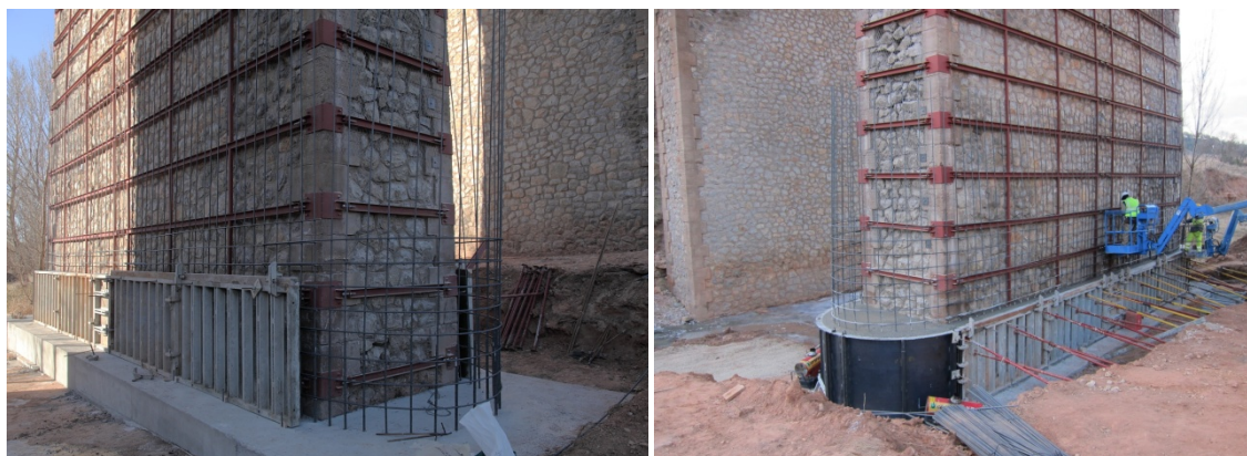
Encofrado y ferralla primer anillo
