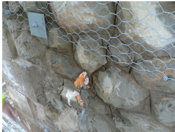
Cosido e inyectado
