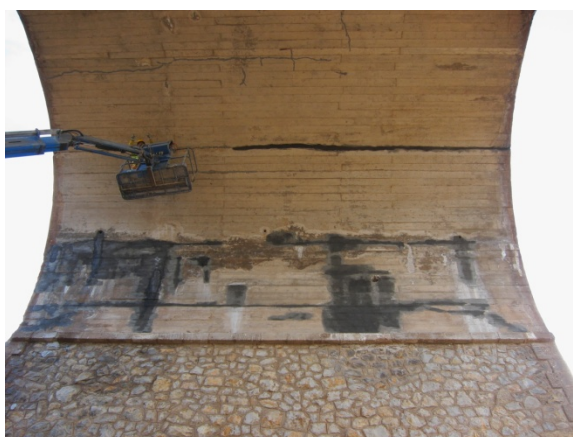
Reparación grieta bóveda
