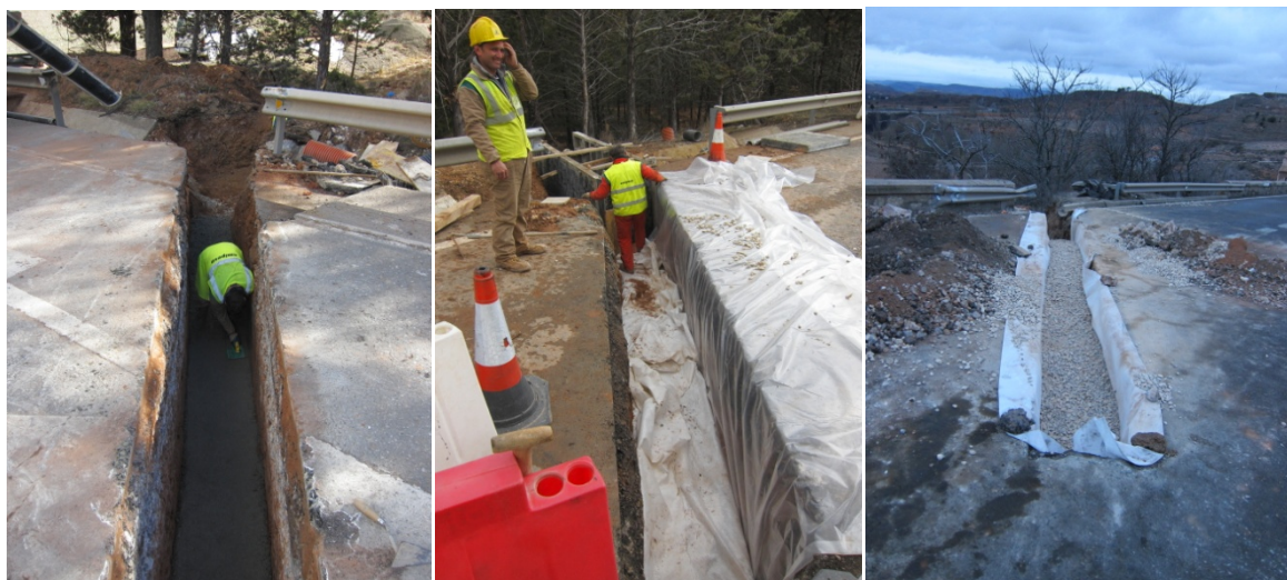
Solera de hormigón dren
