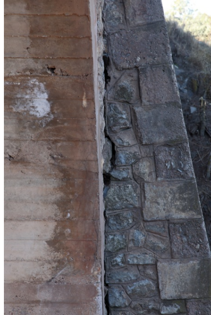
Junta estribo frontal
