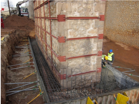
Ejecución zapata apoyo forro
