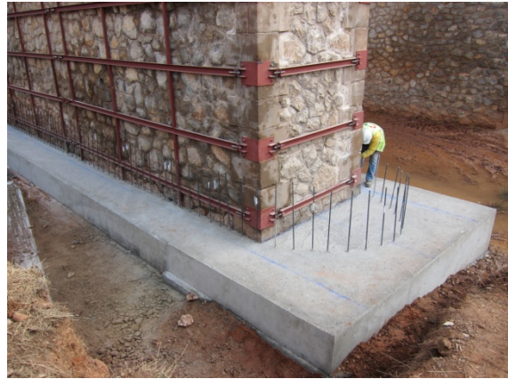
Zapata ejecutada
