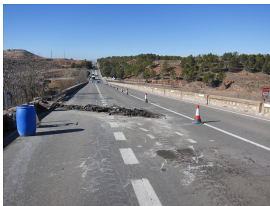
Demolición M.B.C.
