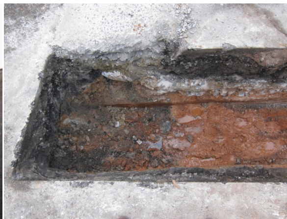
Zanja drenante con agua circulando en el fondo
