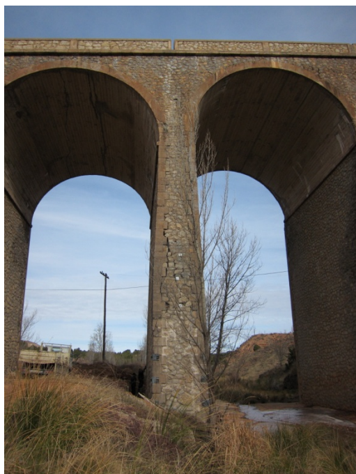
Junta vertical en pila 4
