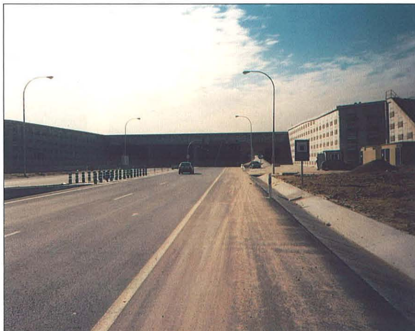
La sección transversal posee características de autovía, con dos carriles de 3,5 m de anchura en cada sentido de la circulación.
