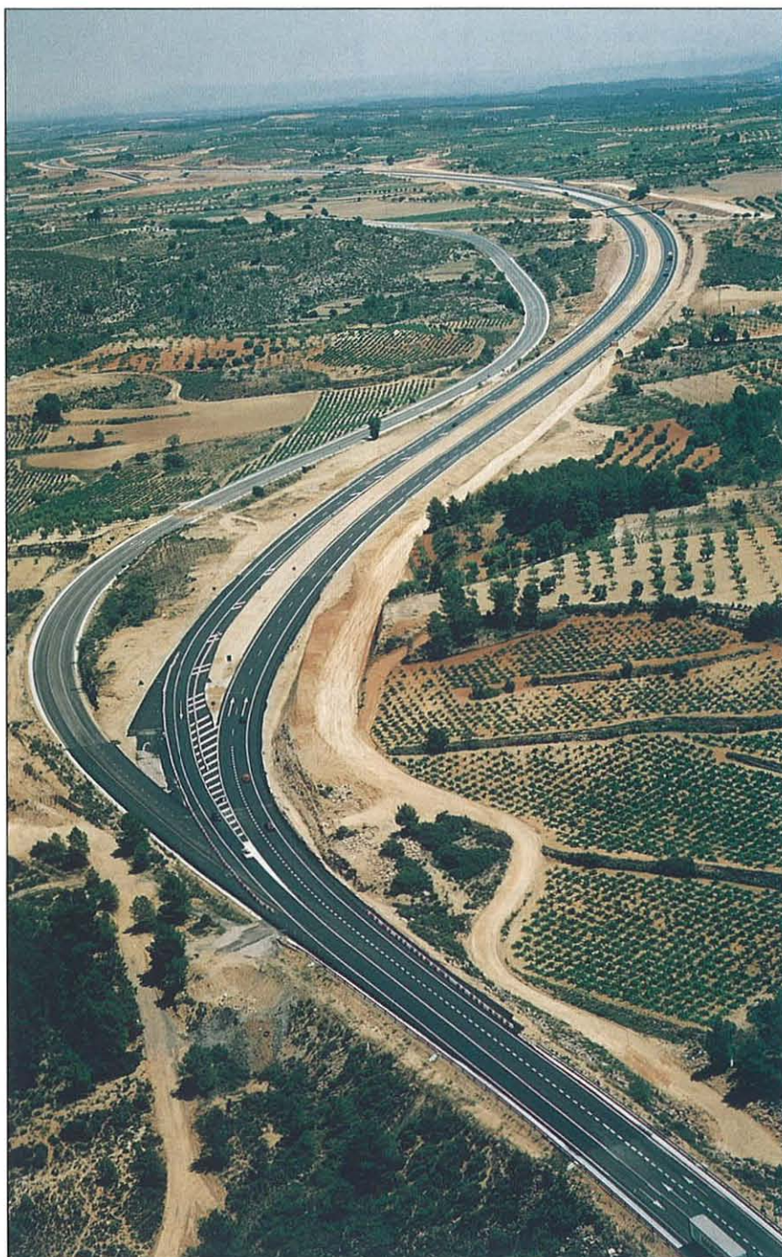
Sólo restan ocho kilómetros para finalizar el tramo Minglanilla - Caudete de las Fuentes.
