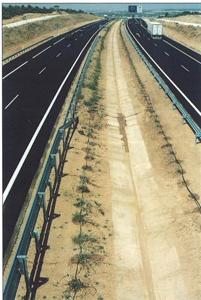
A lo largo del tramo Motilla del Palancar - Minglanilla se han construido seis viaductos, diez pasos superiores y tres inferiores.
