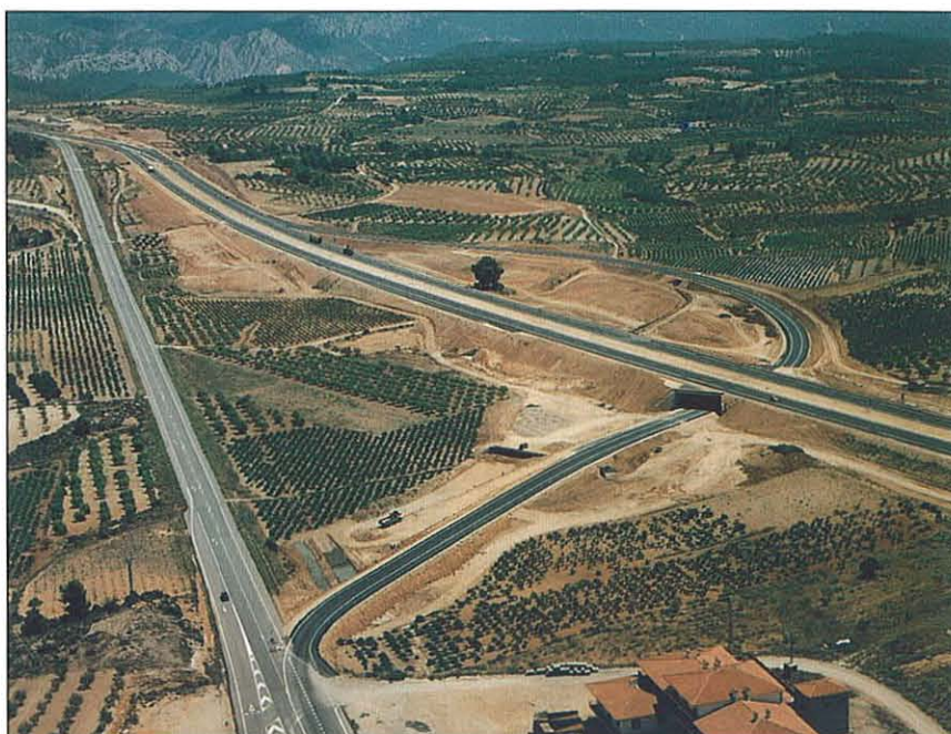
A lo largo del tramo Minglanilla - Caudete de las Fuentes se han dispuesto tres enlaces, un semienlace, tres pasos superiores y uno inferior.
