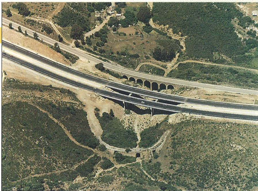
El tronco está formado por dos calzadas con dos carriles de 3,5 m en cada sentido de la circulación.
