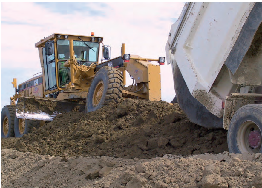
En el control de ejecución de los terraplenes, la unidad o "producto" que se controla es la tongada concluida
