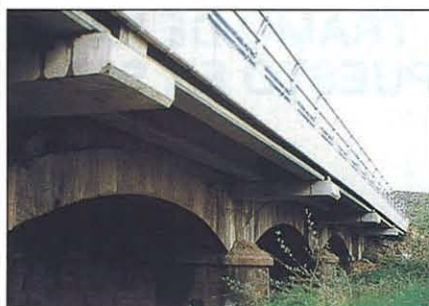
Detalle de ensanchamiento del puente sobre el río Sangustín en la C-515
