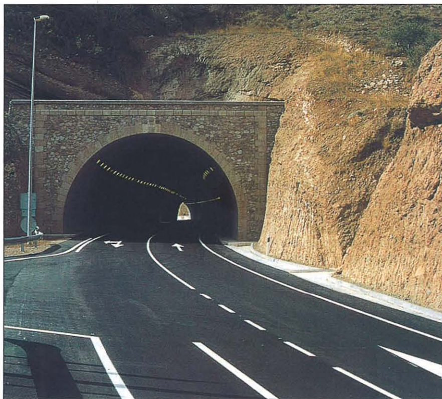
La nueva sección de túnel es de 12 m de anchura con un gálibo mínimo en borde de calzada de 6 m y de 7,20 m en el centro
