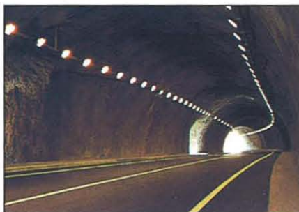
Vista del interior del túnel
