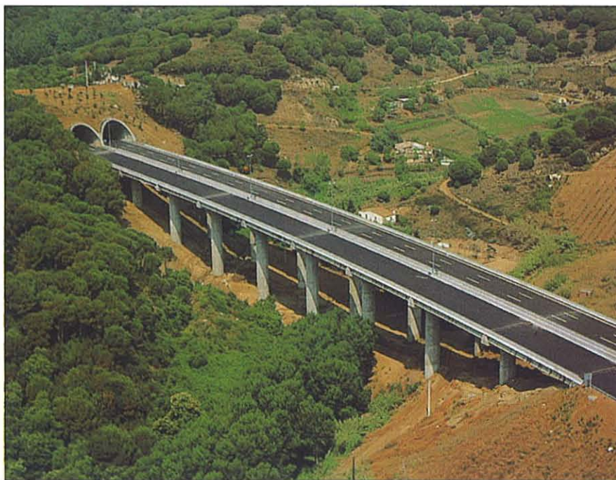
Un total de 40 puentes y viaductos jalonan el recorrido de esta nueva autopista.
