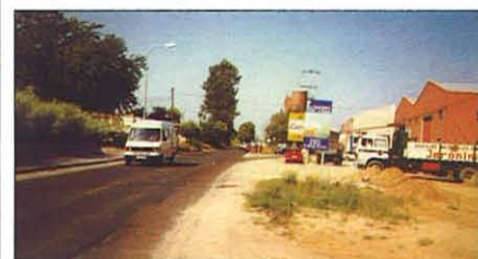
Estado anterior del mismo tramo reflejado en la foto superior.
