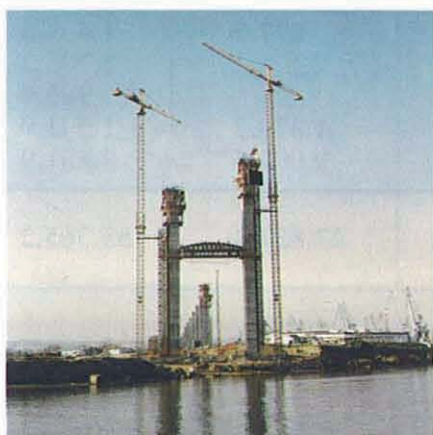
Autovía de circunvalación de Sevilla. Puente del Centenario
