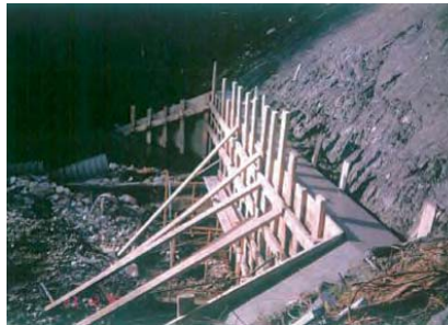
Foto 13. Encofrado y hormigonado
