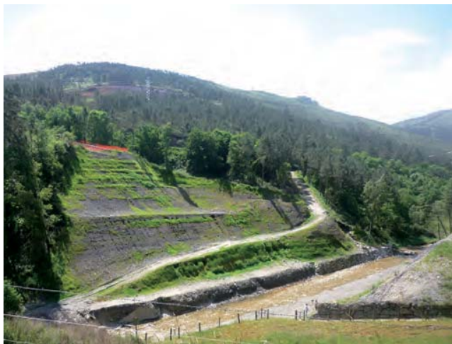
Foto 35. Desmonte de tierras
