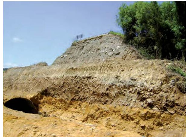
Foto 28. Desmonte de plataforma
