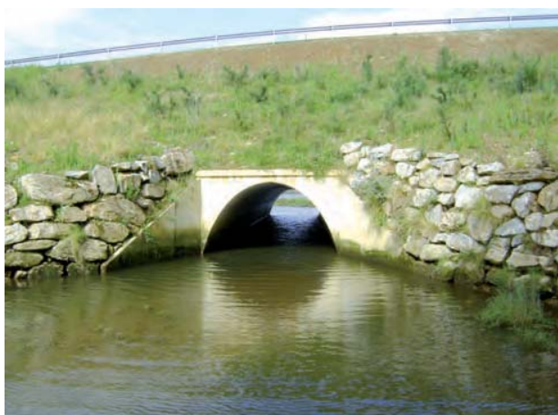
Foto 33. Colocación del elemento prefabricado
