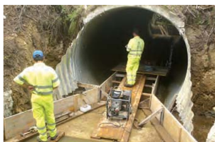
Foto 20. Ejecución de solera
