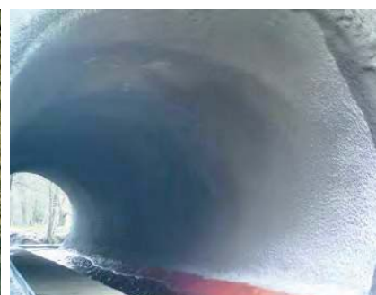
Foto 27. Estado final gunita
