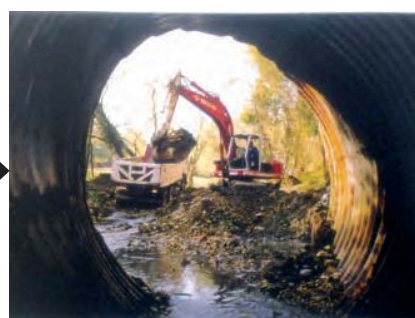
Foto 10. Retirada de material
