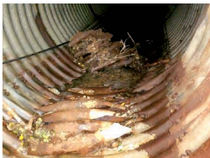
Foto 5. Deformaciones y corrosión
