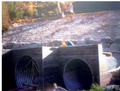
Foto 15. Estabilización talud superior
