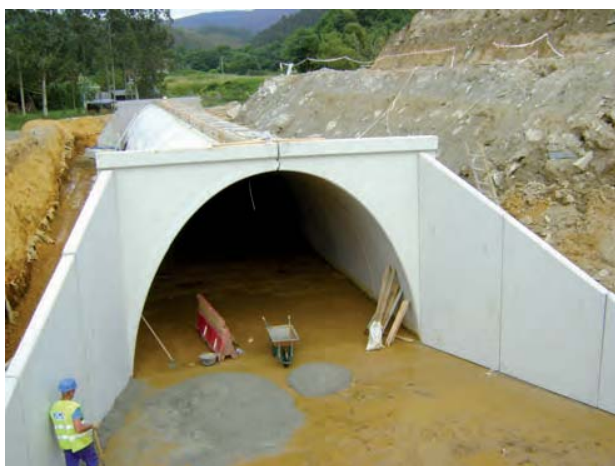
Foto 32. Nueva ODT en servicio
