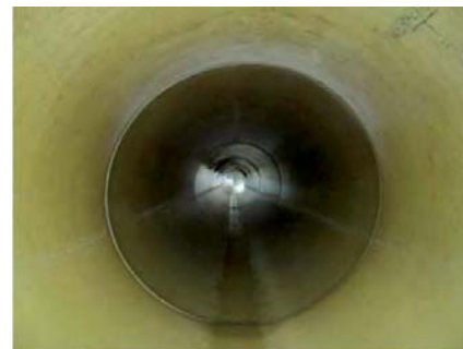
Foto 24. Vista interior tubo PRFV
