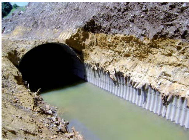
Foto 30. Desmontaje de tubo
