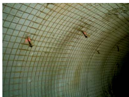
Foto 25. Colocación malla electrosoldada
