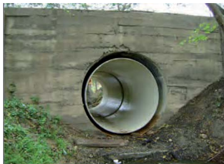
Foto 22. Introducción tubo PRFV
