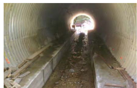
Foto 21. Desencofrado
