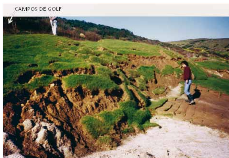
Figura 17. Inestabilidad de un talud en arcilla expansiva en un campo de golf malagueño.
