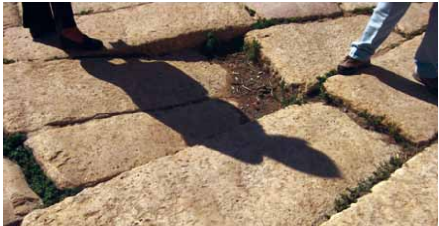
Figura 2. Calzada romana con "socavón" por arrastre de finos inferiores (Jordania)
