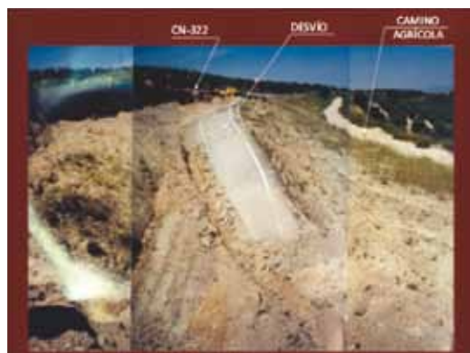
Figura 31. Deslizamiento en Villacarrillo
