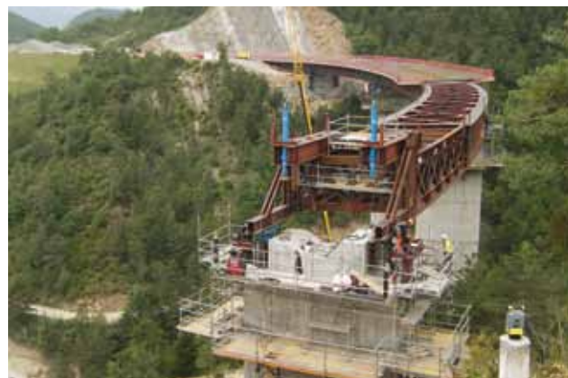
Figura 8. Maniobra empuje de Viaducto Arbisa
