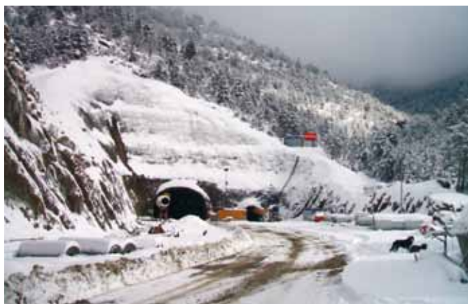
Figura 4. Emboquille sur. Túnel de Petralba
