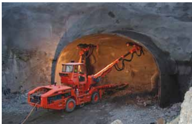
Figura 6. Jumbo perforando túnel de Berroy
