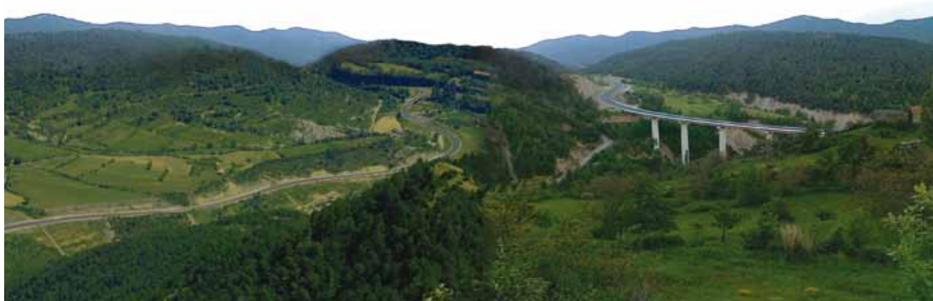
Figura 1. Vista general del tramo Sabiñánigo - Fiscal N-260, Huesca.
