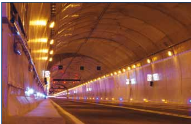
Figura 5. Túnel de Petralba
