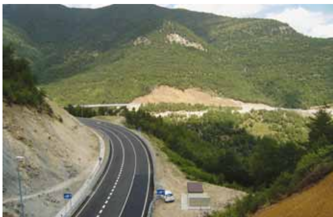
Figura 7. Vistas desde emboquille norte túnel de Berroy
