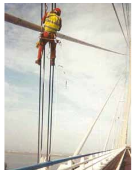
Figura 17. Inspección con alpinista en el puente de Normandía
