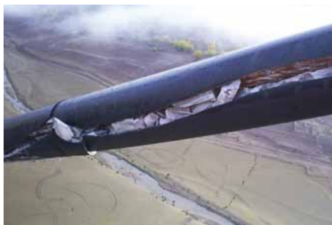
Figura 10. Filtración de agua, expansión de lechada, rotura de vaina y corrosión de los cordones
