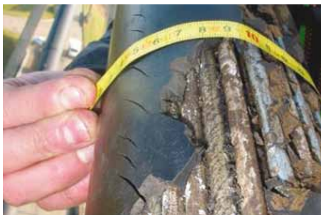
Figura 9. Rotura de vaina de cubrición, falla de lechada y corrosión de los hilos paralelos
