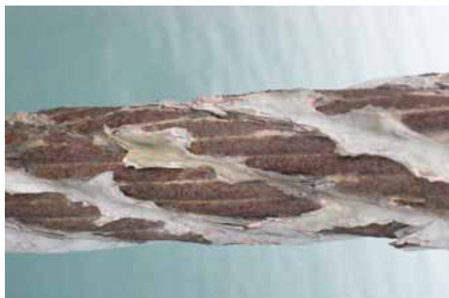
Figura 8. Protección contra la corrosión dañada. Péndolas del puente de las Américas. Panamá
