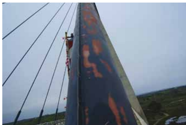
Figura 6. Erosión de pintura en tubos antivandálicos por proyección desde la calzada
