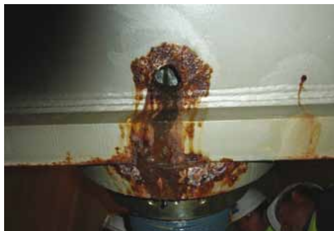
Figura 4. Purgas de tubo de encofrado con presencia de corrosión
