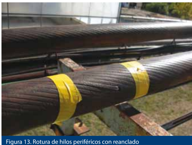
Figura 13. Rotura de hilos periféricos con reanclado
