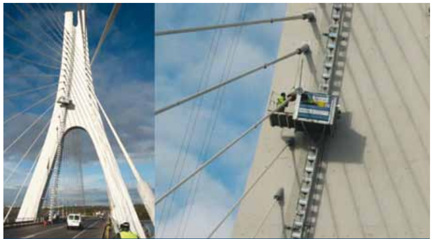
Figura 25. Inspección de los anclajes superiores del Puente de Arade
