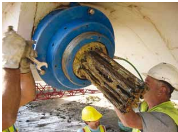
Figura 18. Pesaje por el método de lift-off en el puente de Arade en Portugal
