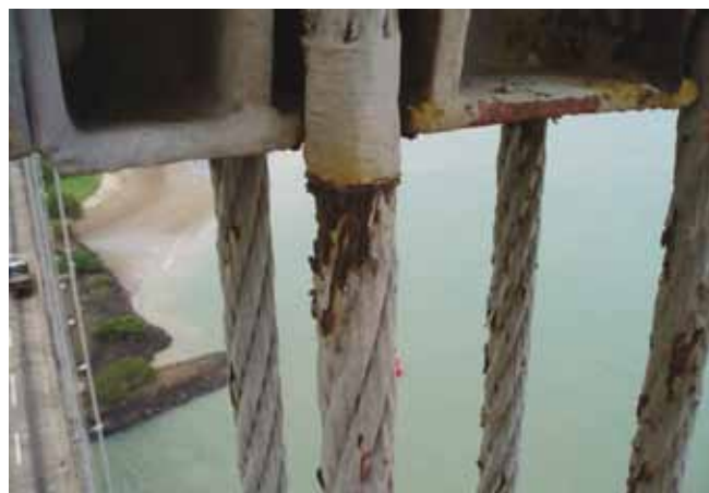
Figura 12. Corrosión y reducción de sección por resquicio y roce
