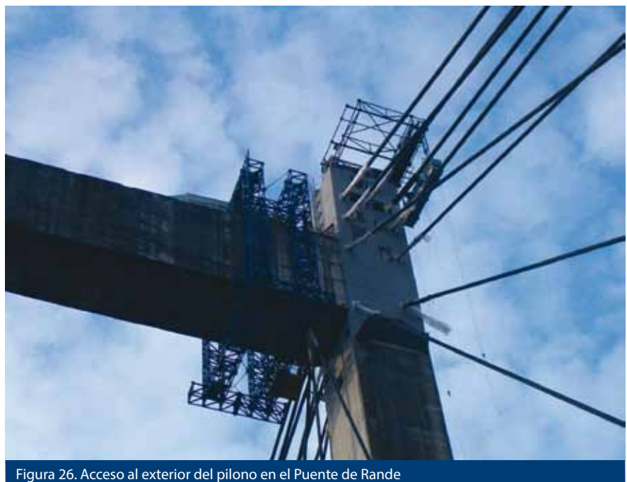
Figura 26. Acceso al exterior del pilono en el Puente de Rande
