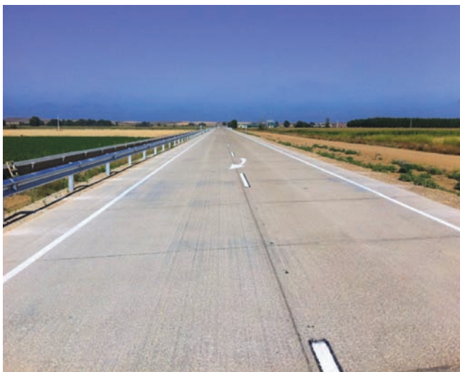
Figura 23. Perspectiva del pavimento de hormigón microfresado.
