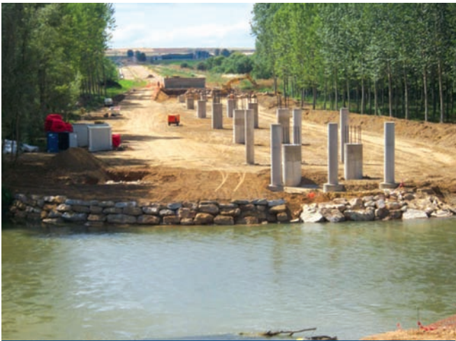
Figura 25. Pilas del segundo tramo del viaducto.
