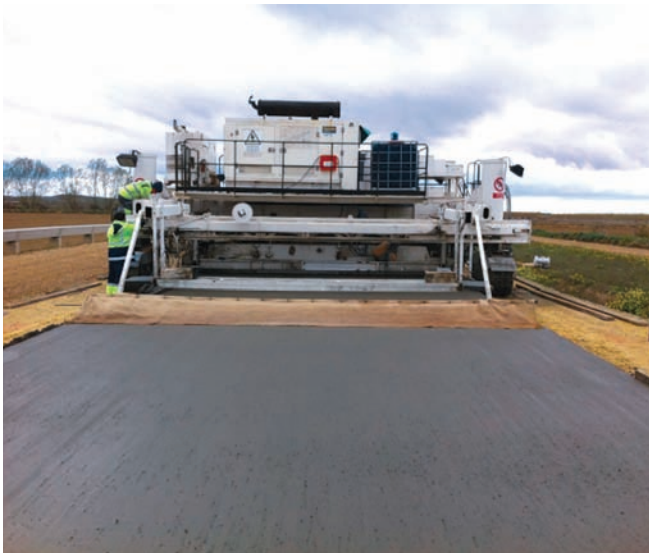
Figura 5. Extendido del hormigón.
