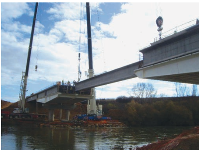
Figura 27. Montaje de vigas.
