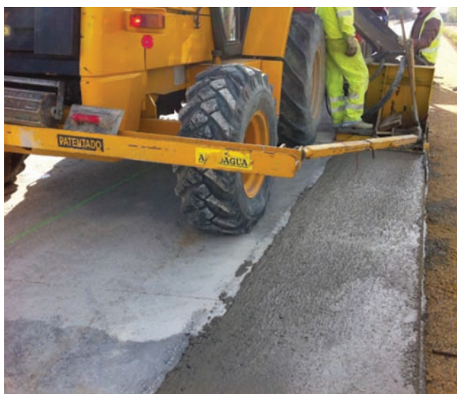
Figura 9. Extendido del arcén de 0,75 m de ancho.
