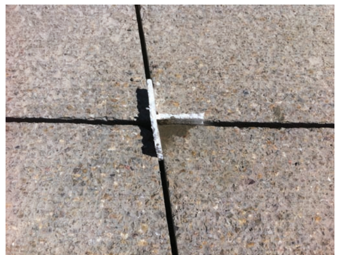
Figura 20. Reparación de junta rota tras el fresado con resina epoxídica.
