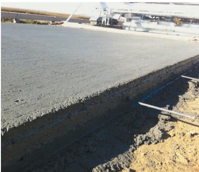
Figura 7. Barras de atado con el arcén.
