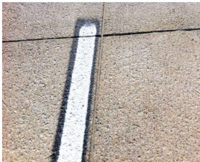
Figura 24. Detalle del pavimento de hormigón microfresado.
