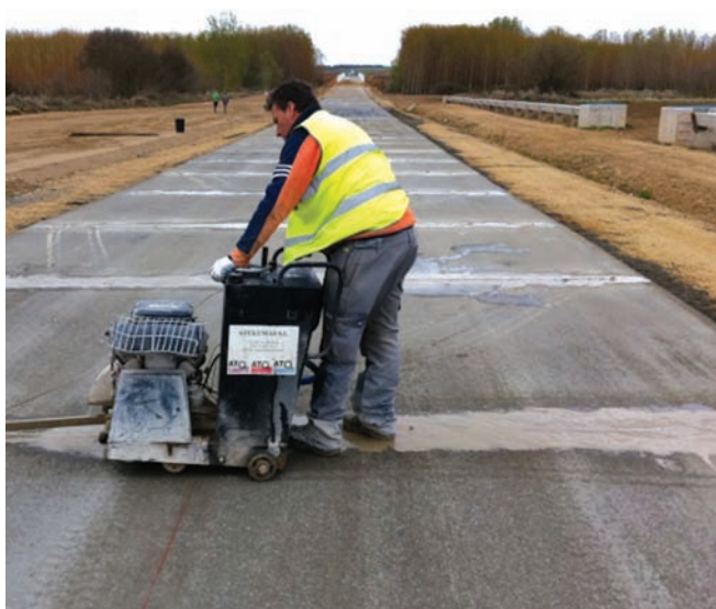
Figura 11. Serrado de juntas.
