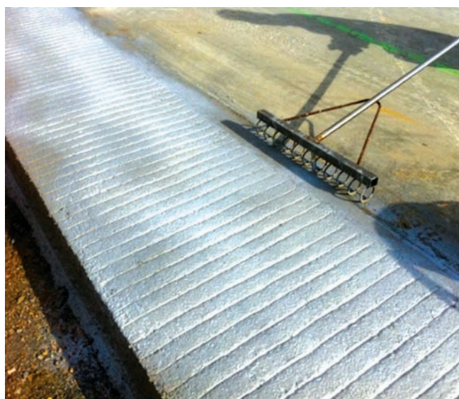
Figura 10. Rayado del arcén de 0,75 m de ancho.
