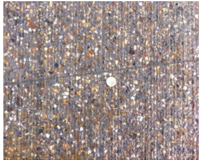
Figura 18. Detalle de junta fresada con mortero previo de protección.
