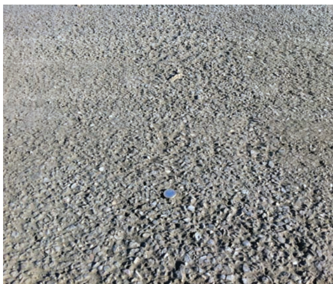
Figura 14. Detalle de tramo con textura de árido visto con terminación irregular.
