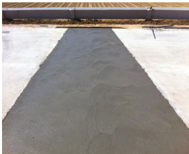
Figura 22. Reparación de una grieta aparecida en el pavimento antes de microfresar (2).
