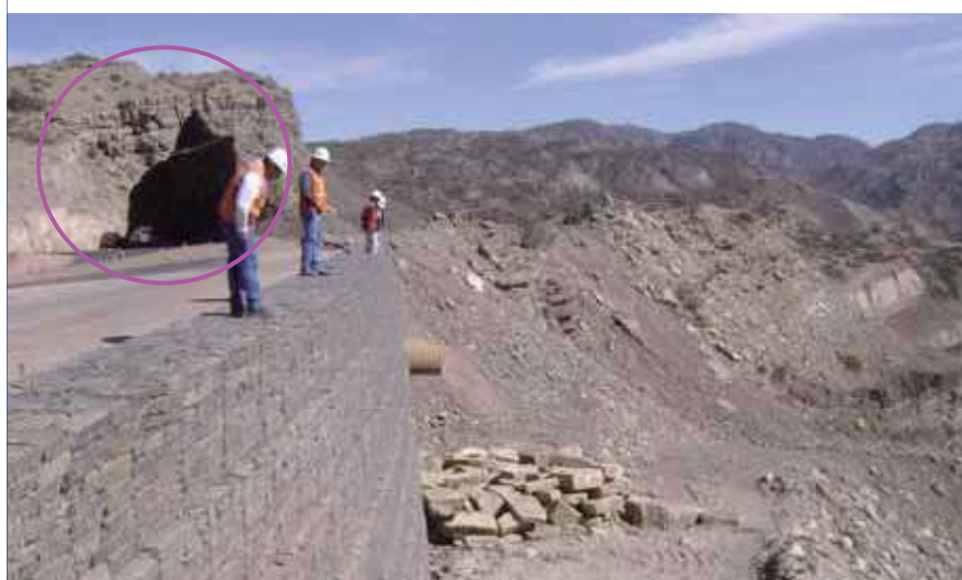
Figura 4. Vista hacia progresivas crecientes desde el muro 18 del corte cajón del macizo en progresiva 16 700, resaltado el lado derecho del mismo. Este muro N° 18 impide correr libremente el eje del camino hacia la derecha
