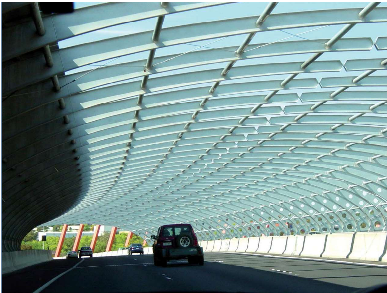
Figura 10. Ejemplo de pantalla antiruido. Red arterial de Melbourne
