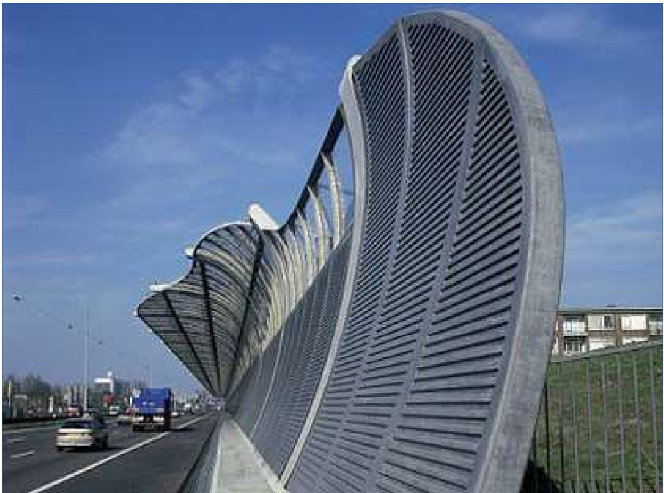
Figura 12 – Barrera en Dordrecht (Pa ses Bajos) con paneles solares incorporados, generadora de ingresos
