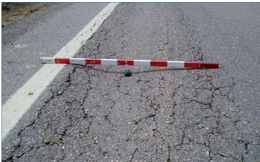
Figura 4. Hundimiento de la rodada
