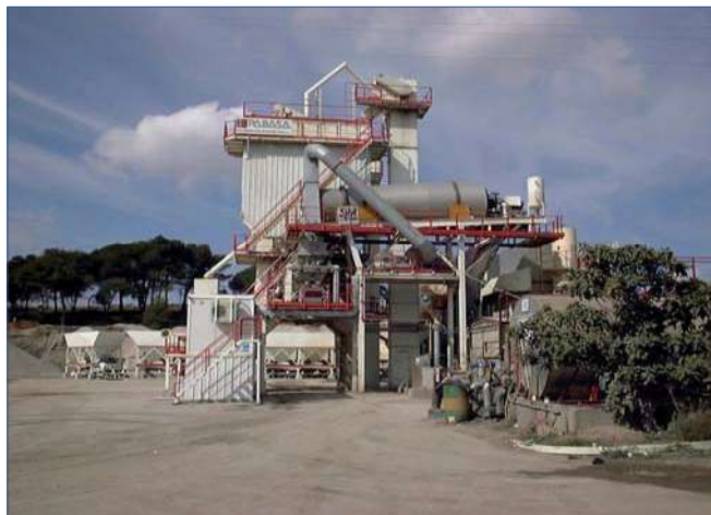
Figura 2. Instalación asfáltica equipada para fabricar reciclado en altas tasas
