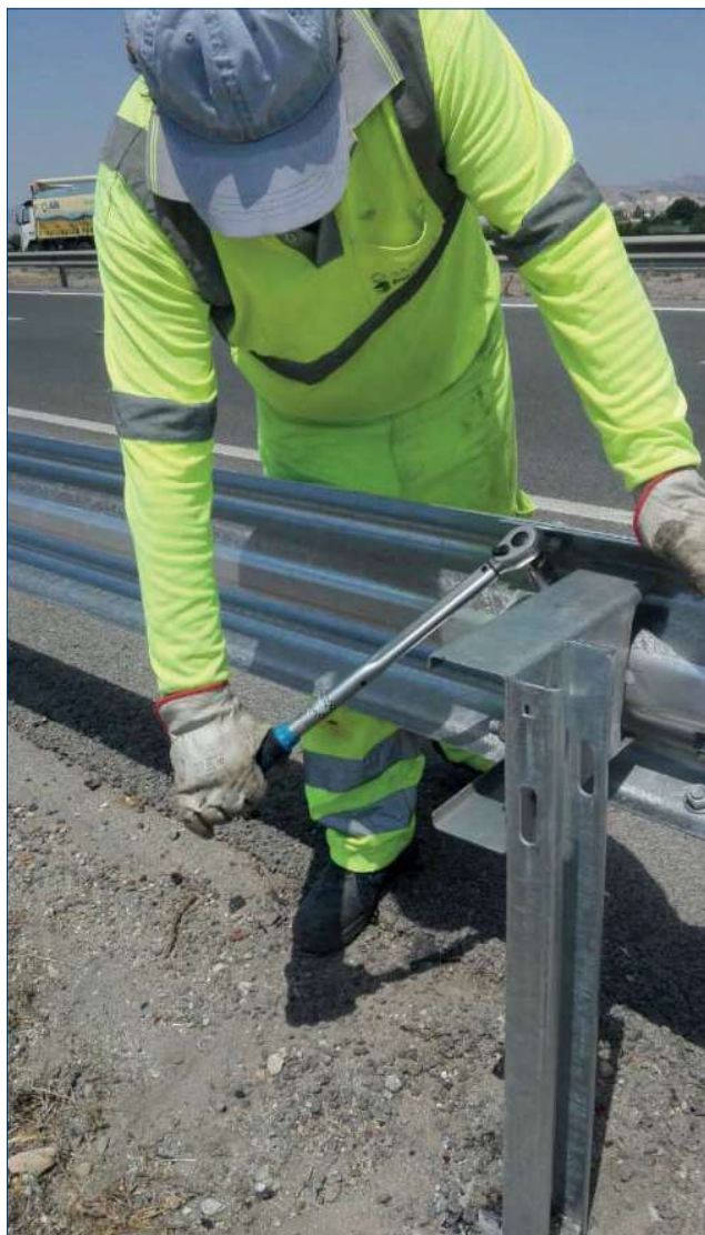
Figura 3. Operario apretando tornillería con llave dinamométrica
