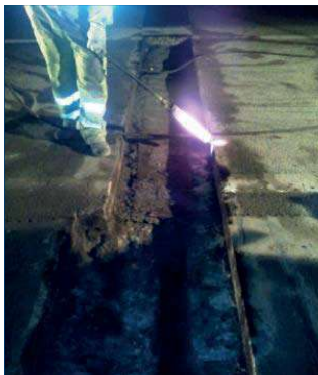
Figura 1. Operario realizando la reposición de la junta de un puente.
