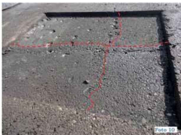
Figura 24 y 25. Continuación de la fisuración sólo en la segunda capa
