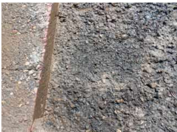
Figuras 13 y 14. Desaparición de las fisuras en las capas inferiores
