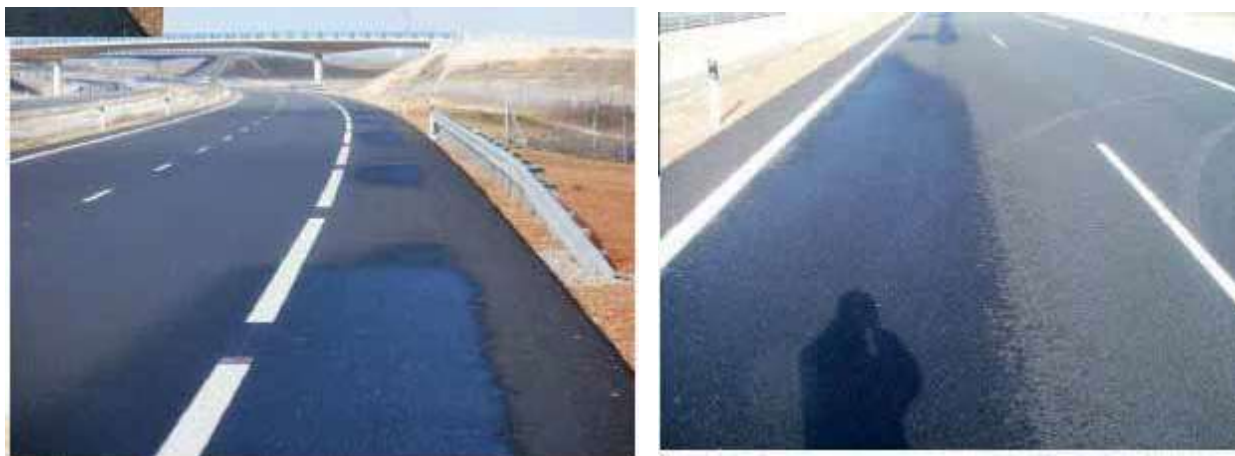
Figura 35 y 36. Formación de zonas con acumulación de agua en una mezcla BBTM -B
