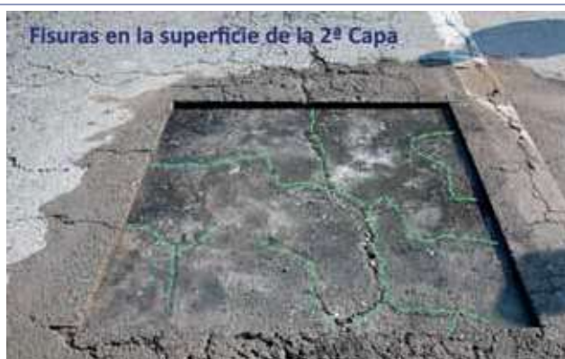
Figura 17 y 18. Falta de adherencia entre la capa de rodadura y la intermedia
