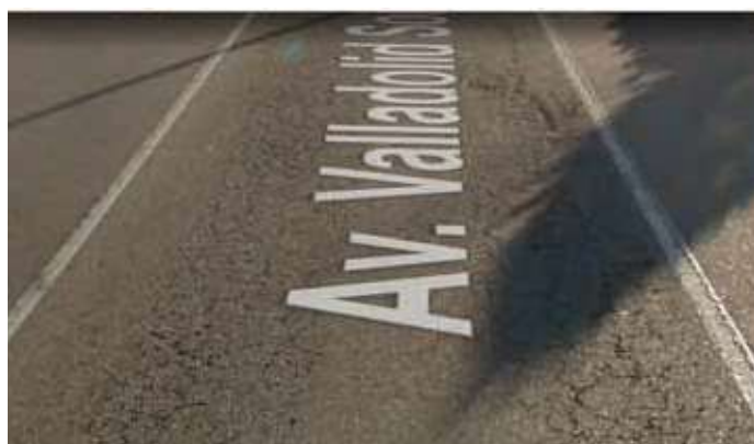
Figuras 11 y 12. Pérdida de betún en capas inferiores
