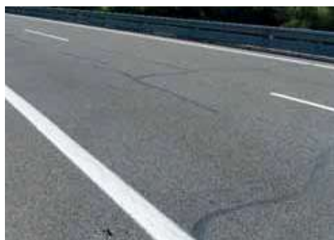
Figura 29 y 30. Fisuración a 90°.
