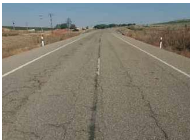
Figuras 3 y 4. Fisuración en rectángulos
