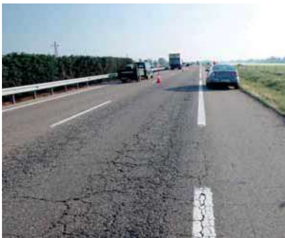
Figura 15 y 16. Agrietamiento importante de la capa de rodadura
