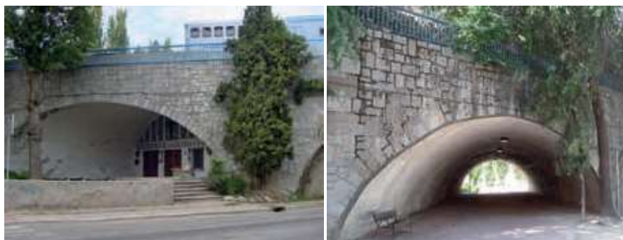
Figura 11. Puente de Arroyo-fresno
