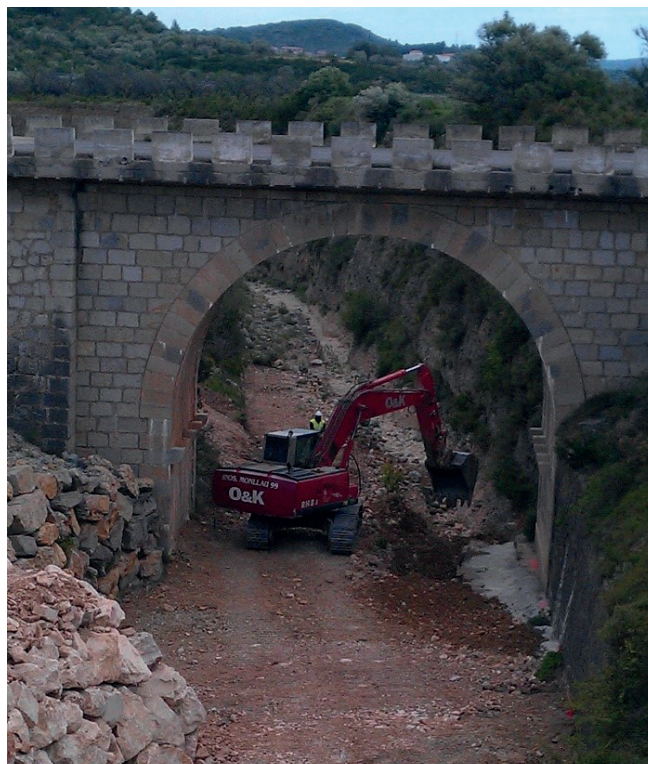
Figura 18. Trabajos para restitución de cauce por erosión en estribo S del puente de 1940. Se trata de una fase previa al escollero del lecho
