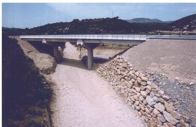
Figura 9. Fotografía de 2002: las obras apenas unos días antes de su apertura al tráfico
