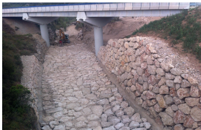
Figura 21. Aspecto de las obras, únicamente a falta de ejecución del rastrillo de entrada
