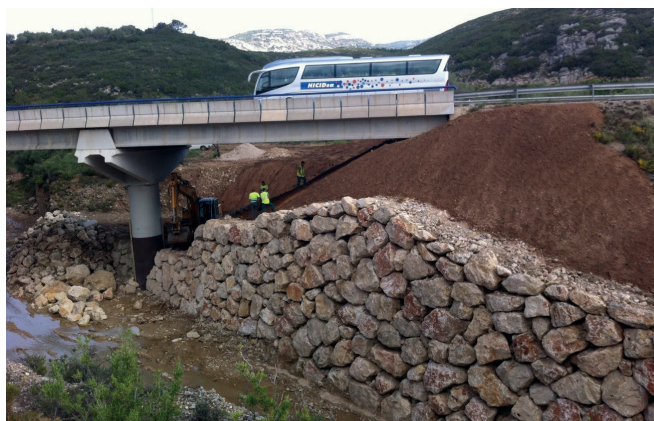
Figura 20. Extendido de tierra vegetal en coronación del muro y cono de tierras del estribo (fase compatible con el paso del tráfico por el viaducto)
