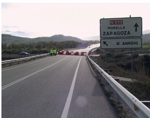
Figura 5. Sección transversal de la Carretera. A la izquierda el puente de 1940, al frente el viaducto construido en 2002
