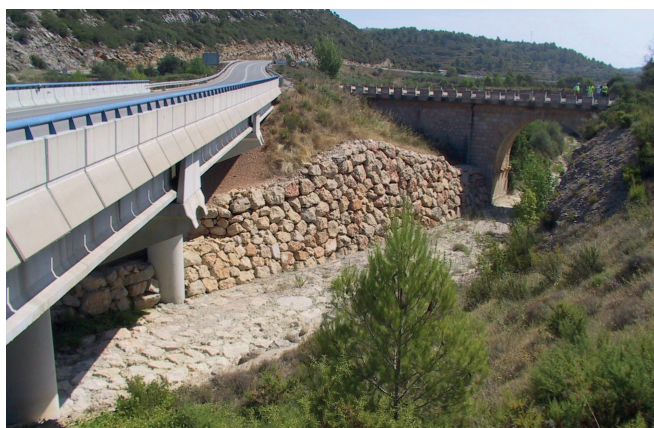
Figura 22. Vista general de las obras, a los siete años de la incidencia (agosto de 2020)
