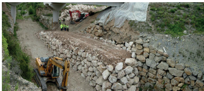
Figura 17. Primera etapa de la reconstrucción del muro de escollera en el estribo norte del viaducto de 2002
