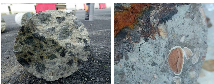
Figura 11. Aureolas blanquecinas observadas alrededor de los áridos de los testigos extraídos sin necesidad de microscopía (A la izquierda, estructura de la carretera SG-20; a la derecha, estructura del Nudo de Colmenar)
