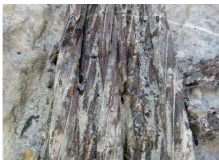
Figura 17. A la izquierda, cordones corroídos e hilos rotos; a la derecha, consistencia anormal de lechada con formación de espuma (Estructura del Nudo de Colmenar)
