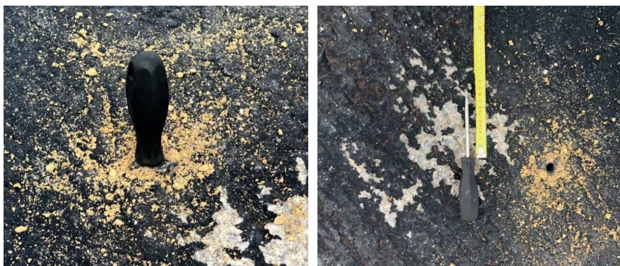
Figura 15. Chequeo de los tubos de purga para comprobación de la colmatación de los mismos (Estructura de la SG- 20)
