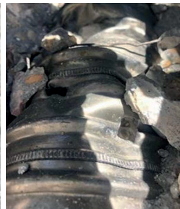
Figura 18. Falta de conexión entre tubo de purga y vaina de pretensado (Estructura del Nudo de Colmenar)
