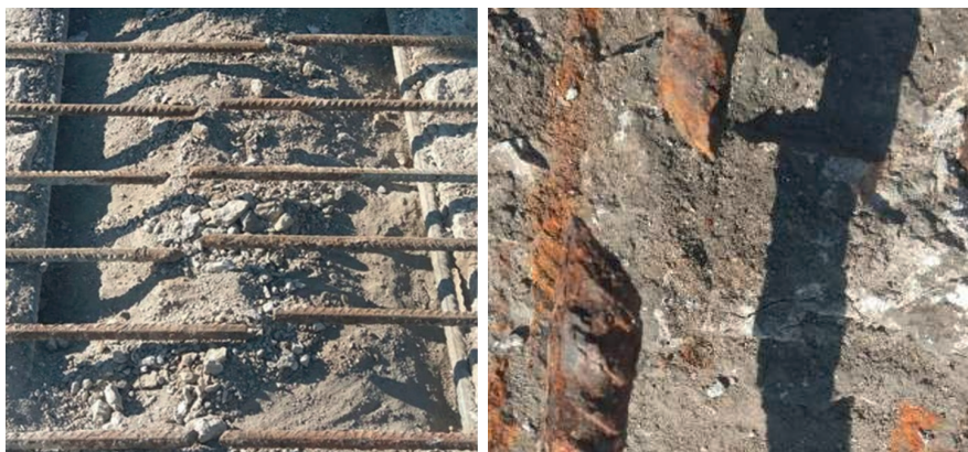
Figura 12 – Detalle de las barras seccionadas en la estructura del Nudo de Colmenar
