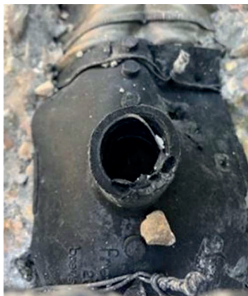
Figura 18. Falta de conexión entre tubo de purga y vaina de pretensado (Estructura del Nudo de Colmenar)
