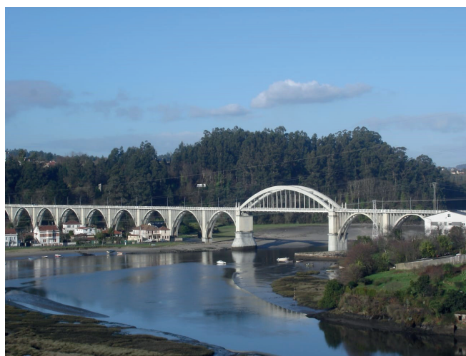
El Viejo Puente del Pedrido
