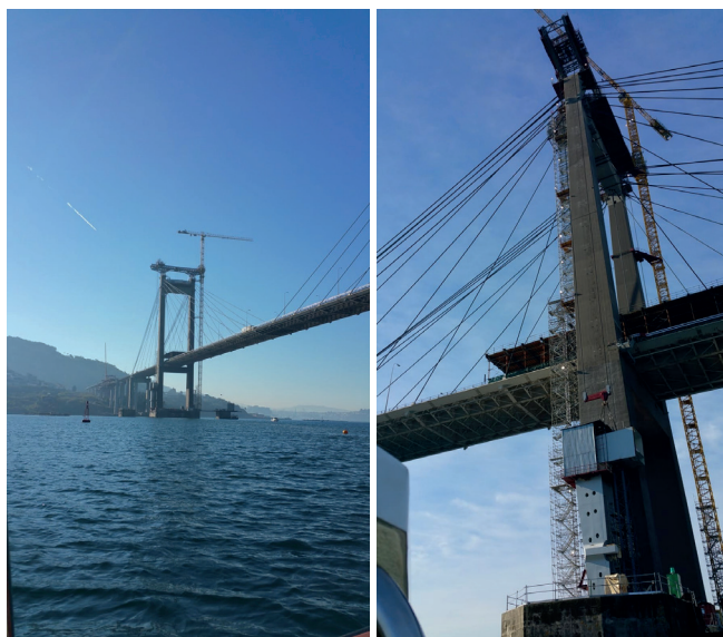
PUENTE DE RANDE. Ampliación. Directora de las obras Ana Fernández Prieto, Ingeniera de Caminos, C. y P. de AUDASA
