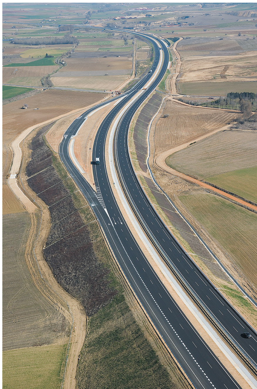
Vista aérea del área de descanso y cruce con la carretera de Fuentelcarnero.
