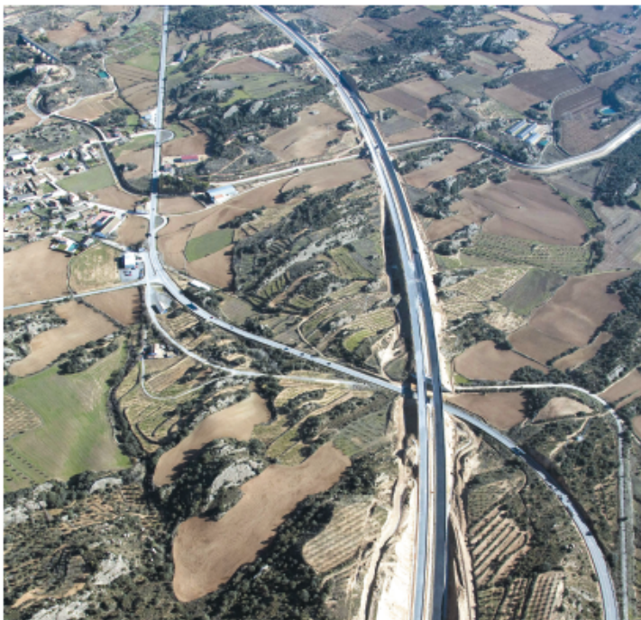
Vista aérea del tramo finalizado a la altura del p.k. 3+300.
