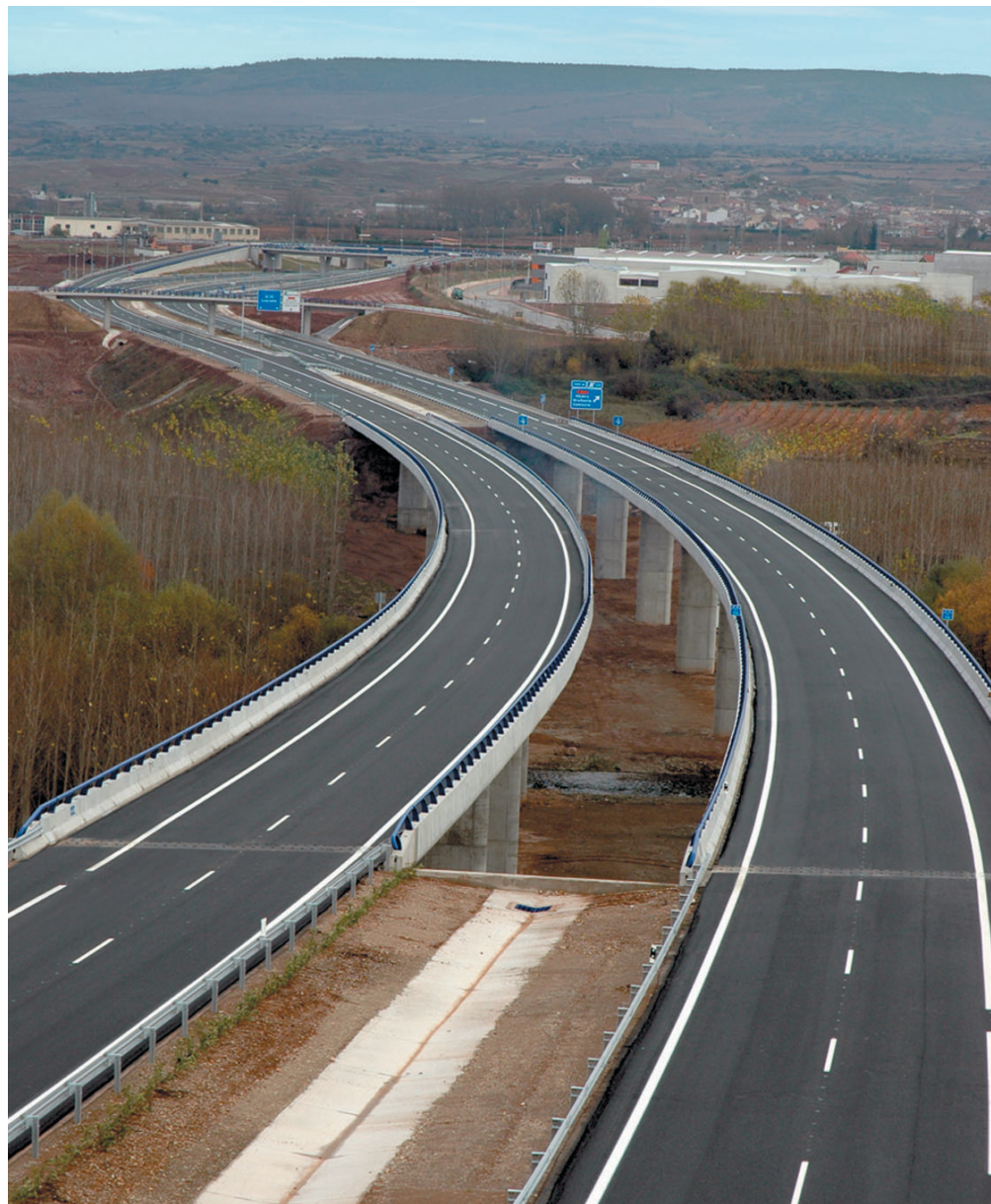
Vista general del tramo finalizado en diciembre de 2008 y que ha supuesto una inversión total de 33,67 millones de euros.
