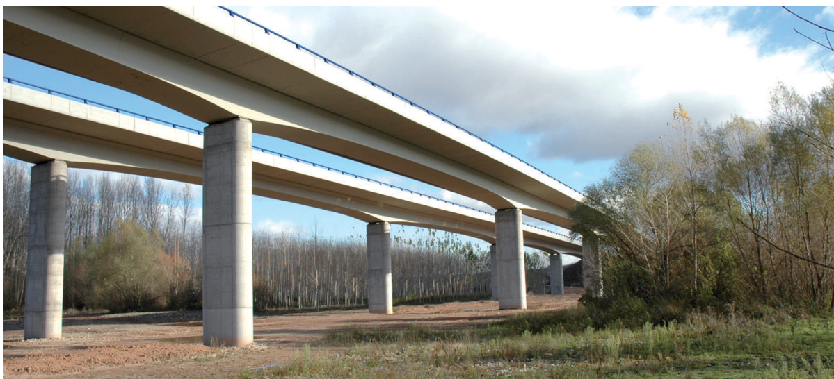
Puente sobre el río Najerilla, de 508 m de longitud.
