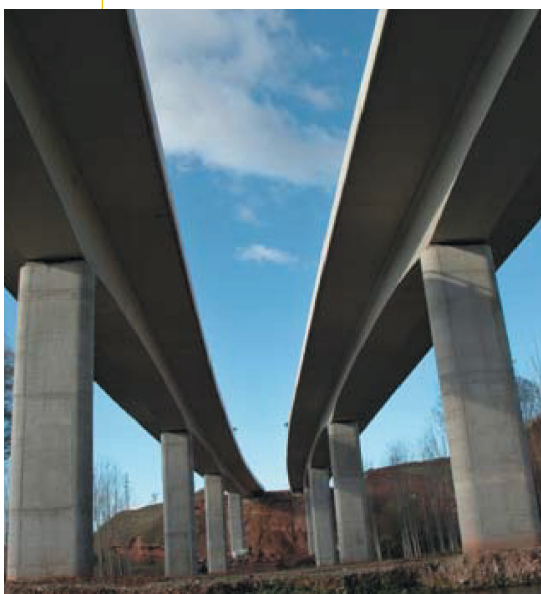
Detalle de las pilas del viaducto sobre el río Najera.
