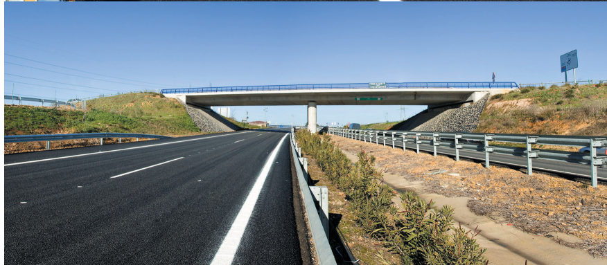
Diversas vistas panorámicas del tramo inaugurado
