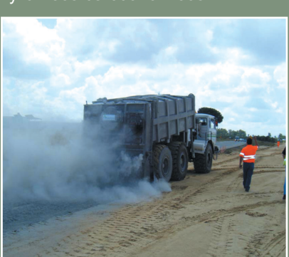
Procedimiento de estabilización con cemento.
