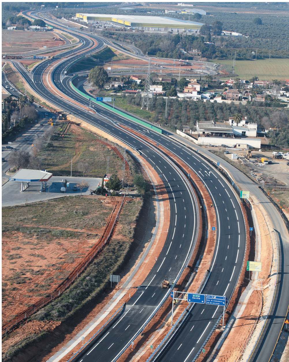
Vista panorámica del tramo abierto al tráfico.
