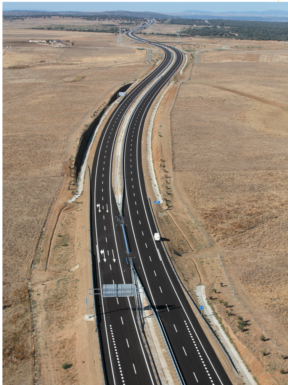
Vista general del inicio del tramo finalizado.
