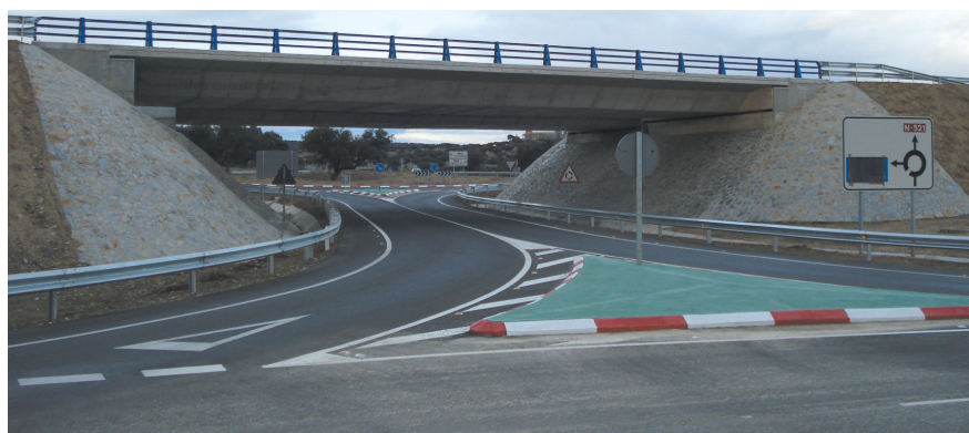
Foto izquierda: Estructura sobre el río Gibranzos. Foto superior: Paso inferior en el enlace de Plasenzuela.
