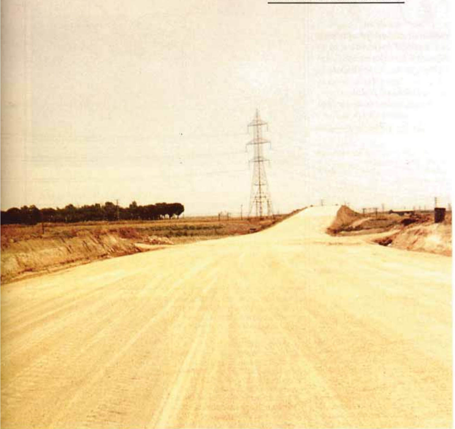
Circunvalación sur-oeste de Leganés. Tramo de ensayo con una base granular drenante (abierta, sin finos)
