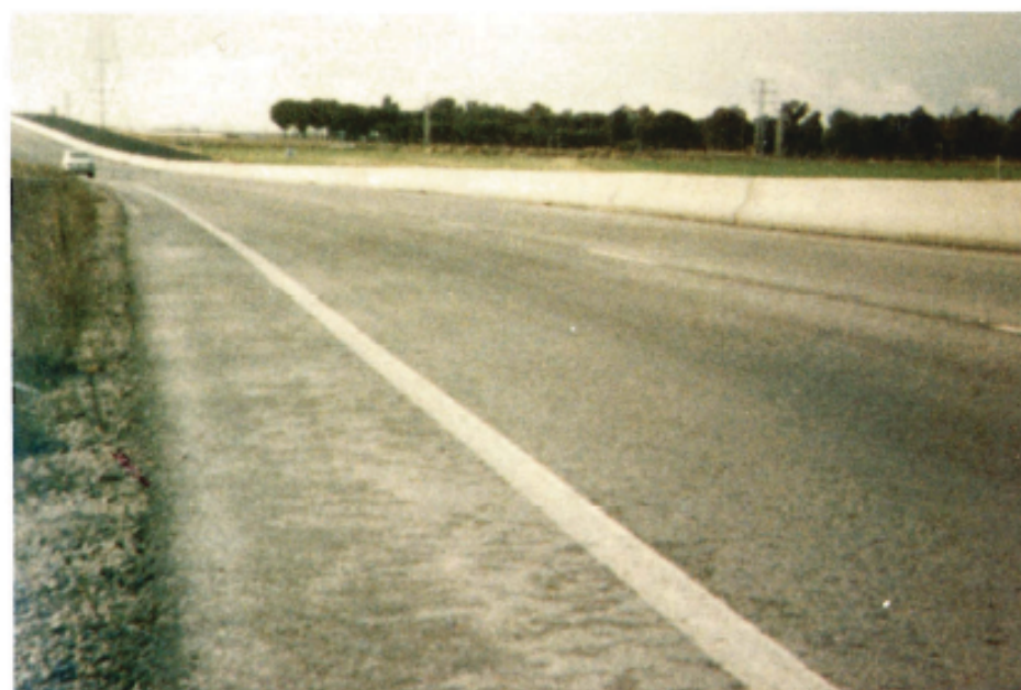
Circunvalación sur-oeste de Leganés a los dos años de puesta en servicio. (No han aparecido irregularidades superficiales ni defectos estructurales)
