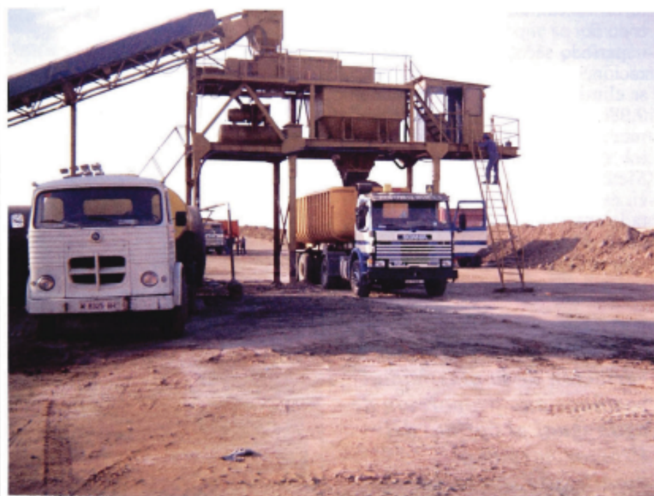
Dosificación del material en obra
