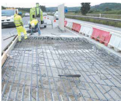
Foto 12. Colocación de la armadura.
