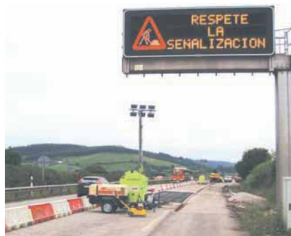
Foto 8. Señalización y corte del carril.
