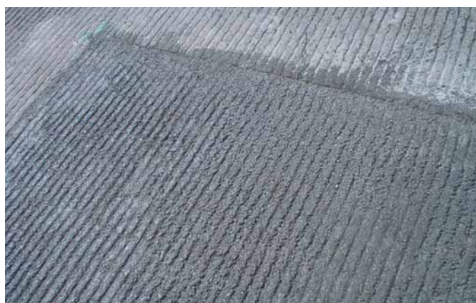
Foto 20. Reparación después de dos días de tráfico.
