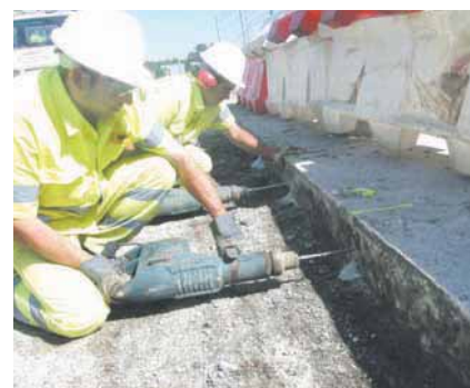
Foto 13. Perforación para las barras de atado.
