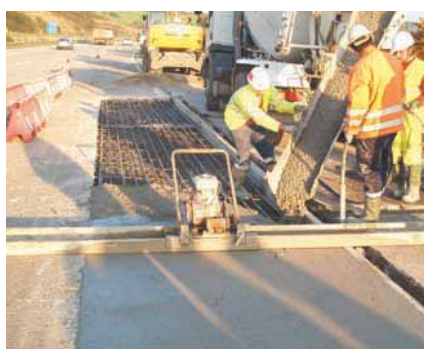
Foto 14. Hormigonado y terminación con regla vibrante.
