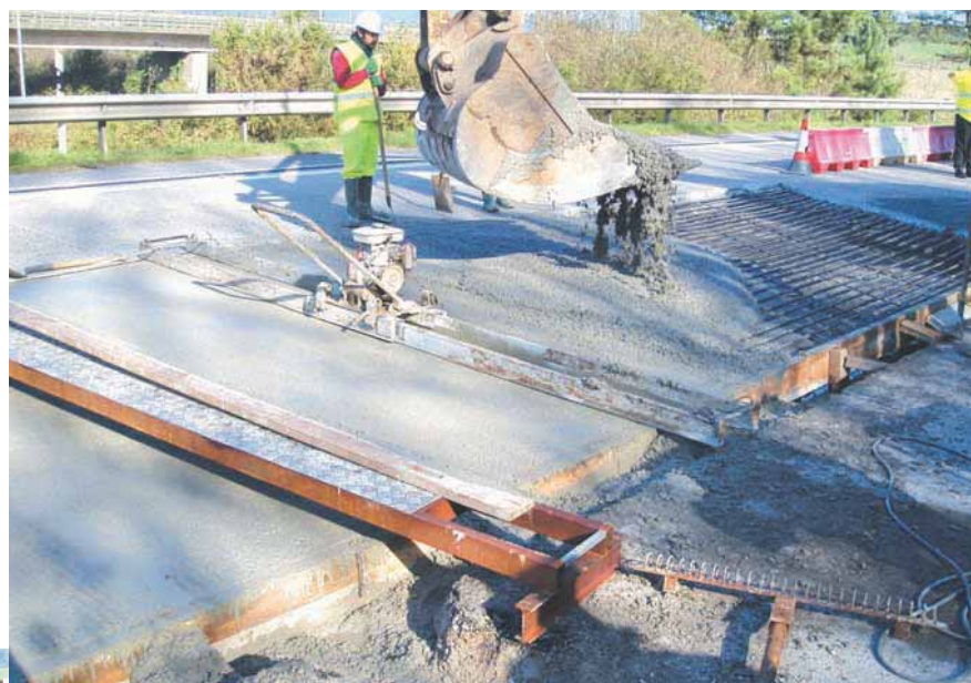
Foto 7. Detalle del hormigonado repartido con el cazo de la pala y vibrado con regla.
