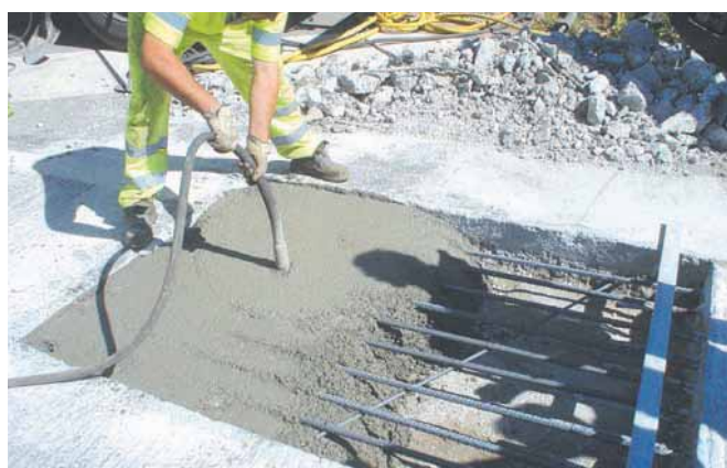
Foto 21. Colocación y vibrado del hormigón.
