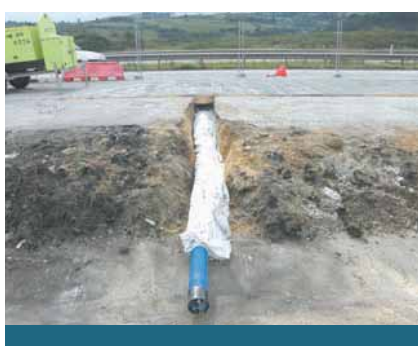
Foto 18. Salida del dren y reposición del arcén.
