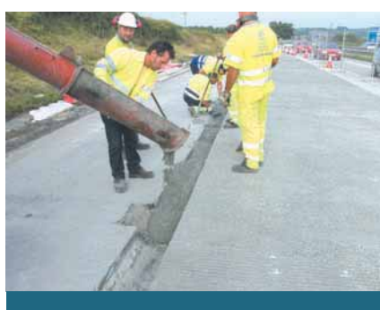
Foto 17. Hormigonado del hueco dejado por el encofrado longitudinal del arcén.
