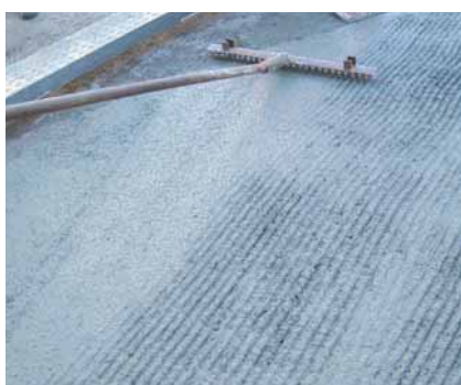
Foto 15. Realización de textura transversal.
