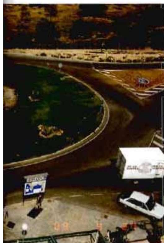
Intersección de la C-719 con el acceso a la Costa d'En Blanes
