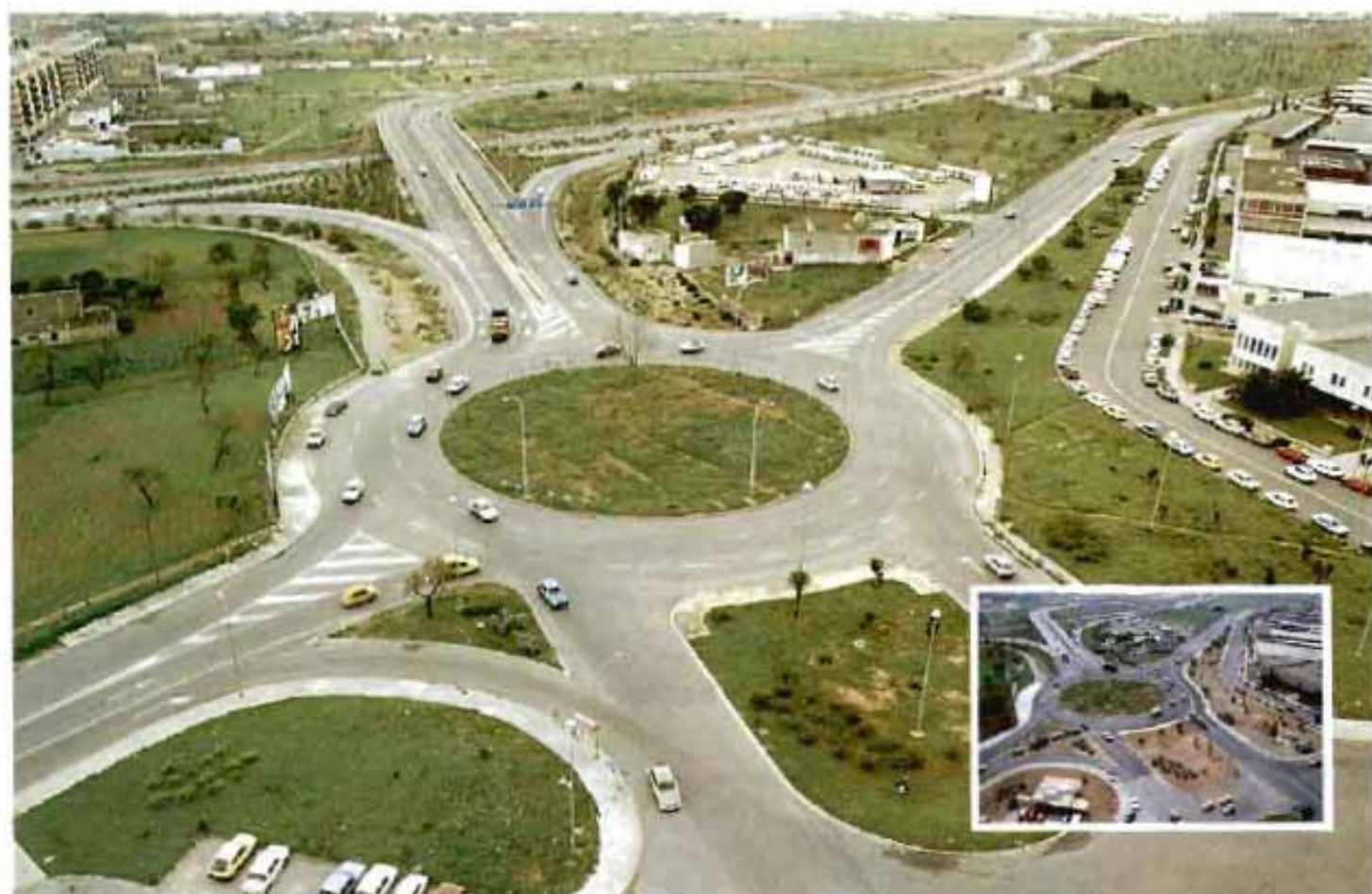
Intersección Polígono Industrial
