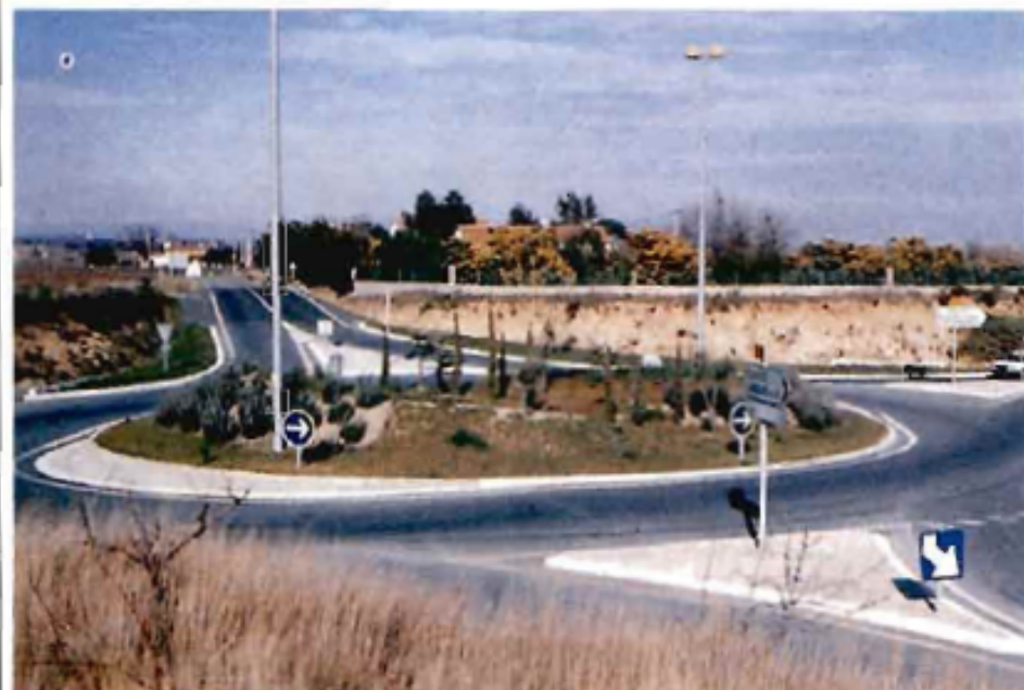
En este ejemplo la parte nostruida de la composición puede ser atravesada ocasionalmente por los vehículos sin afectar a la vegetación
