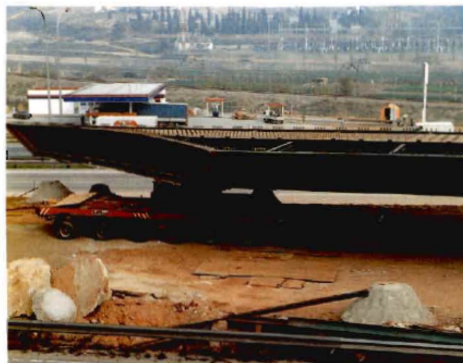
Fig. 18. Puente sobre La Meridiana. Traslado por terraplén.
