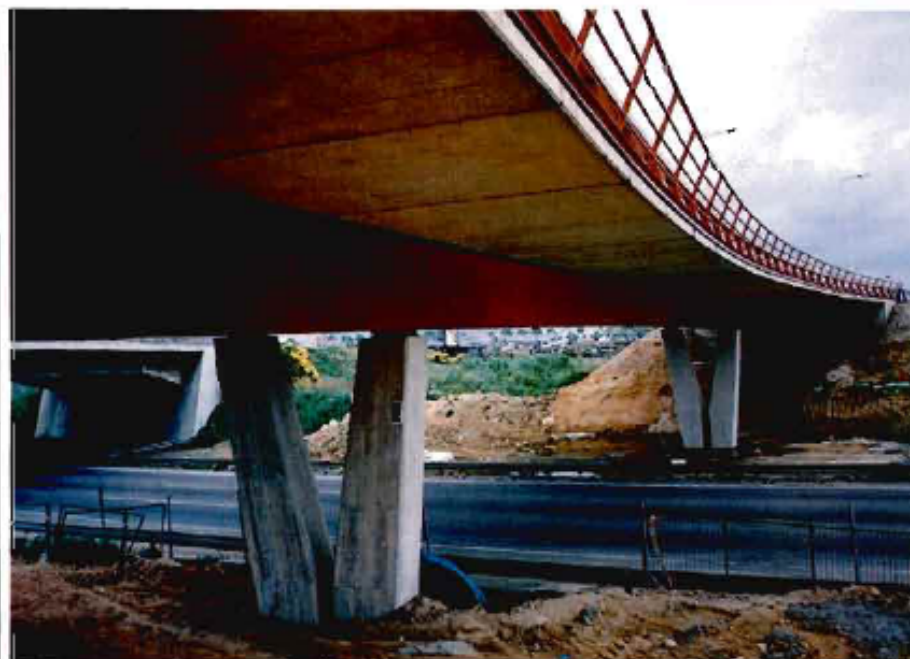
Fig. 30. Puente mixto con losas prefabricadas postensadas longitudinalmente sobre la autopista A-19. Barcelona.
