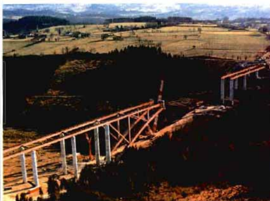
Fig. 29. Montaje del arco del viaducto "Eau Rouge".
