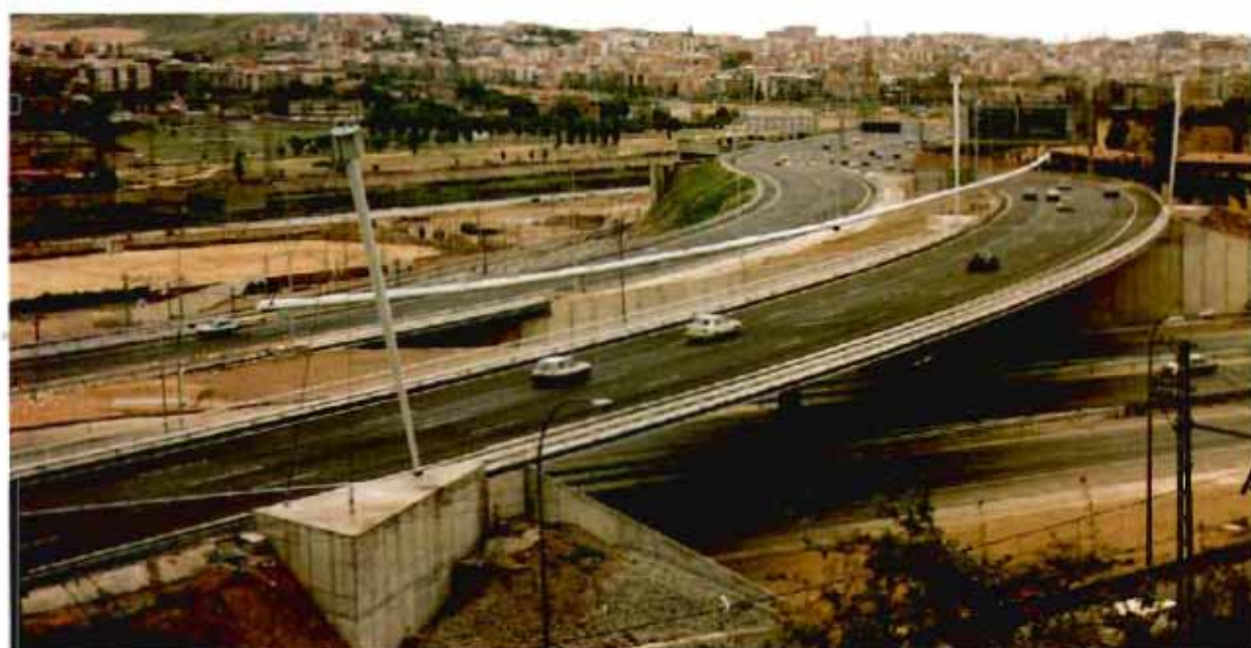
Fig. 16. Puente sobre La Meridiana. Cinturón litoral de Barcelona. Vista aérea.
