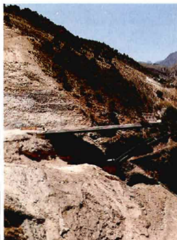
Fig. 14. Puente de hormigón.
