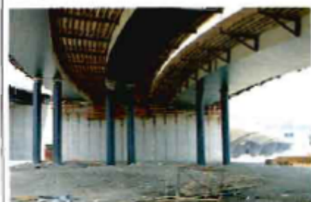
Fig. 34. Detalle de encofrados de tableros mixtos en el nudo de Trinidad, Barcelona.
