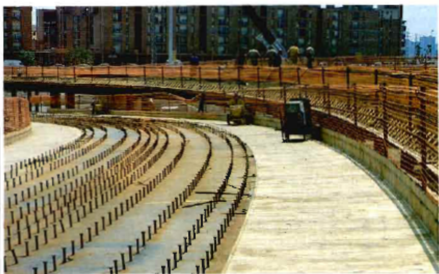
Fig. 33. Encofrado y pernos conectadores de tableros mixtos en el nudo de Trinidad, Barcelona.
