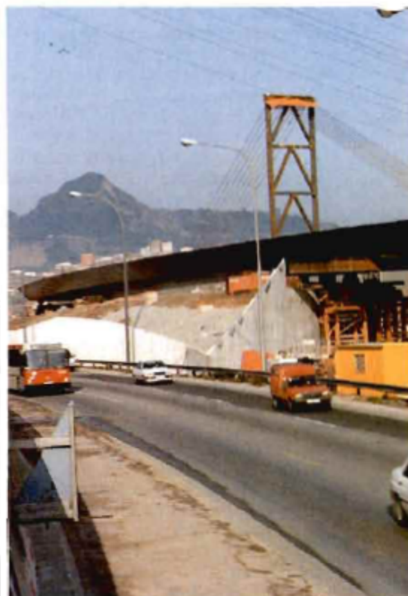
Fig. 19. Puente sobre la carretera.
