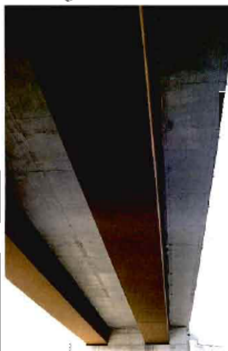
Fig. 22. Tablero puente FF.CC. en el tramo norte del by-pass. Madrid.
