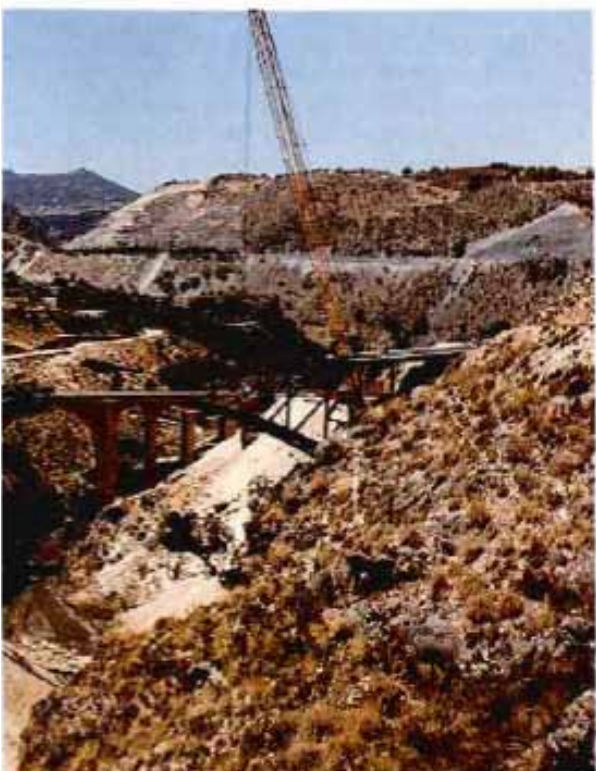
arco, N-323 Granada-Motril. Durante la construcción.
