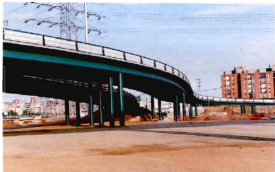
Fig. 32. Tableros y pilas mixtas del nudo de Trinidad Barcelona.
