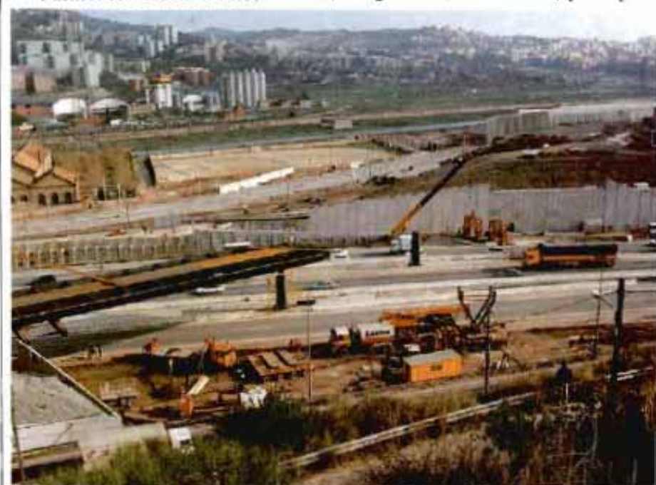
Fig. 17. Puente sobre La Meridiana. Vista del cajón y pilas metálicas.
