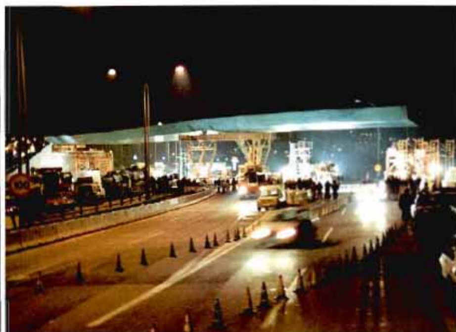
Fig. 20. Puente sobre La Meridiana. Traslado nocturno sobre autopistas A-17 y A-18.
