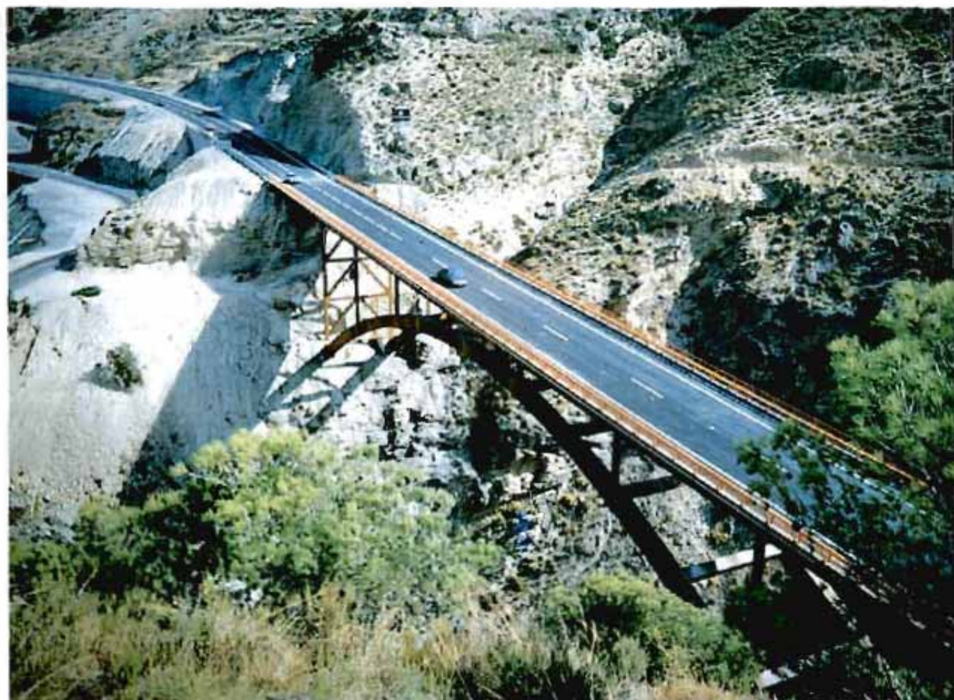
Puente en arco de 95 m de luz en la N-323 Granada-Motril, en servicio.
