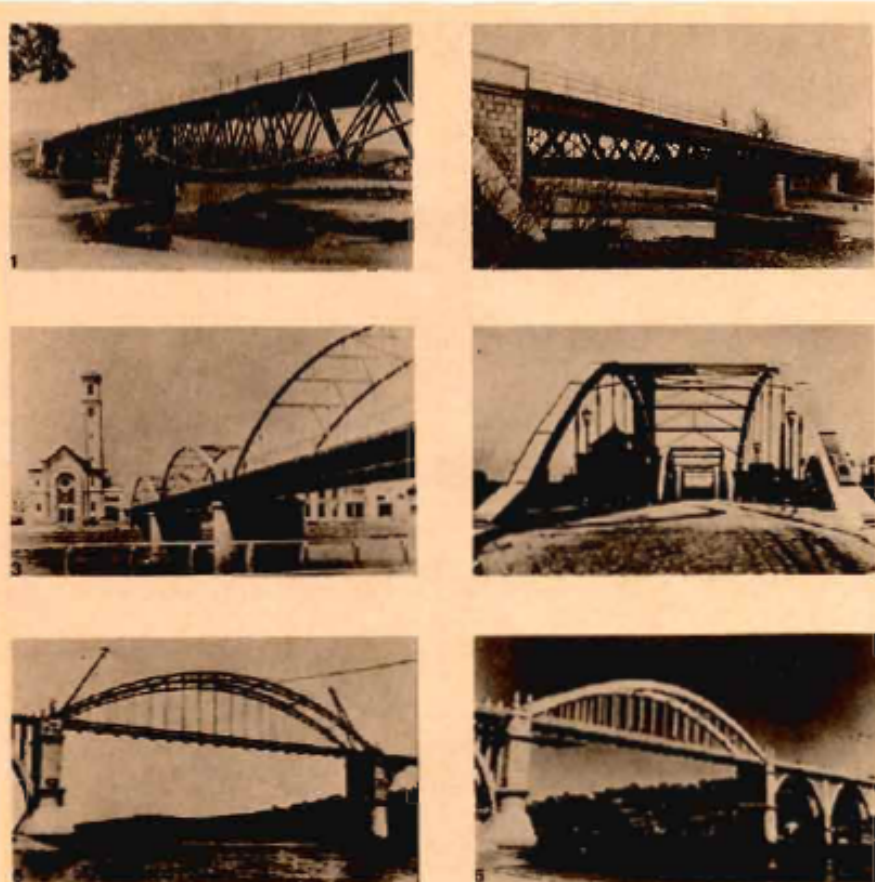
Fig. 1. Puentes mixtos proyectados por Eduardo Torroja.
