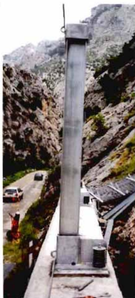
Poste de la pantalla dinámica con los muelles de elastómeros en la base.
