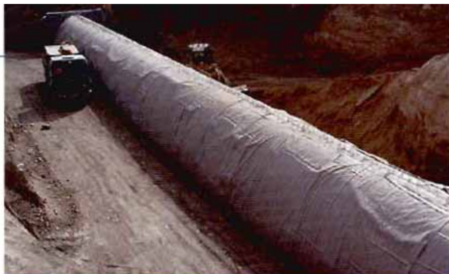
Drenaje de una bóveda triarticulada en la autovía Alhendín-Durcal en la provincia de Granada (Terratest).
