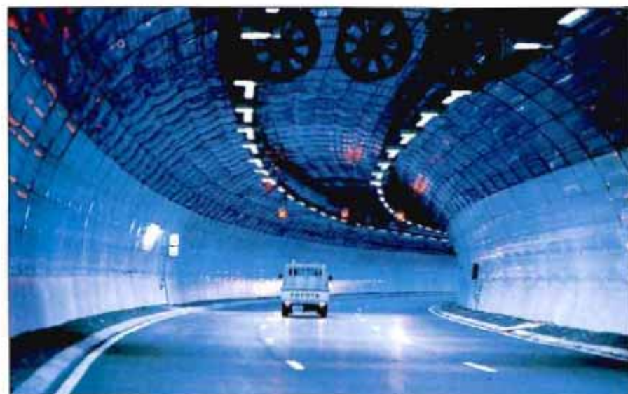
Túnel en Oslo (Noruega)
