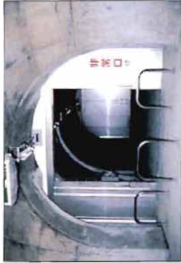
Galería de escape de un túnel japonés.
