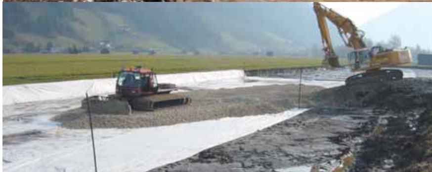
Utilización de geosintéticos en suelos colapsables (foto superior) y estabilización de suelos blandos (foto inferior).
